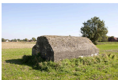
Vue de trois-quarts vers le sud-est Phot. Pierre Thibaut IVR31_20155901689NUCA
