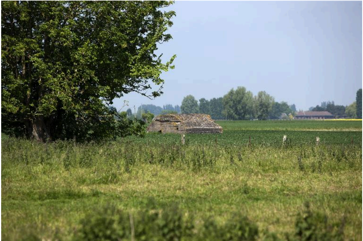
Vue générale, vers le nord ouest
