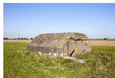
vue de trois-quarts vers le nord-est Phot. Pierre Thibaut IVR31_20155901688NUCA
