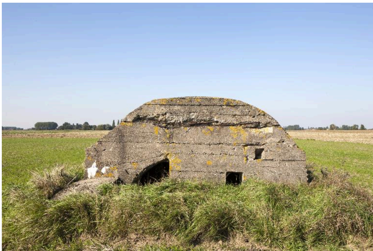
Entrée sur l'élévation sud
