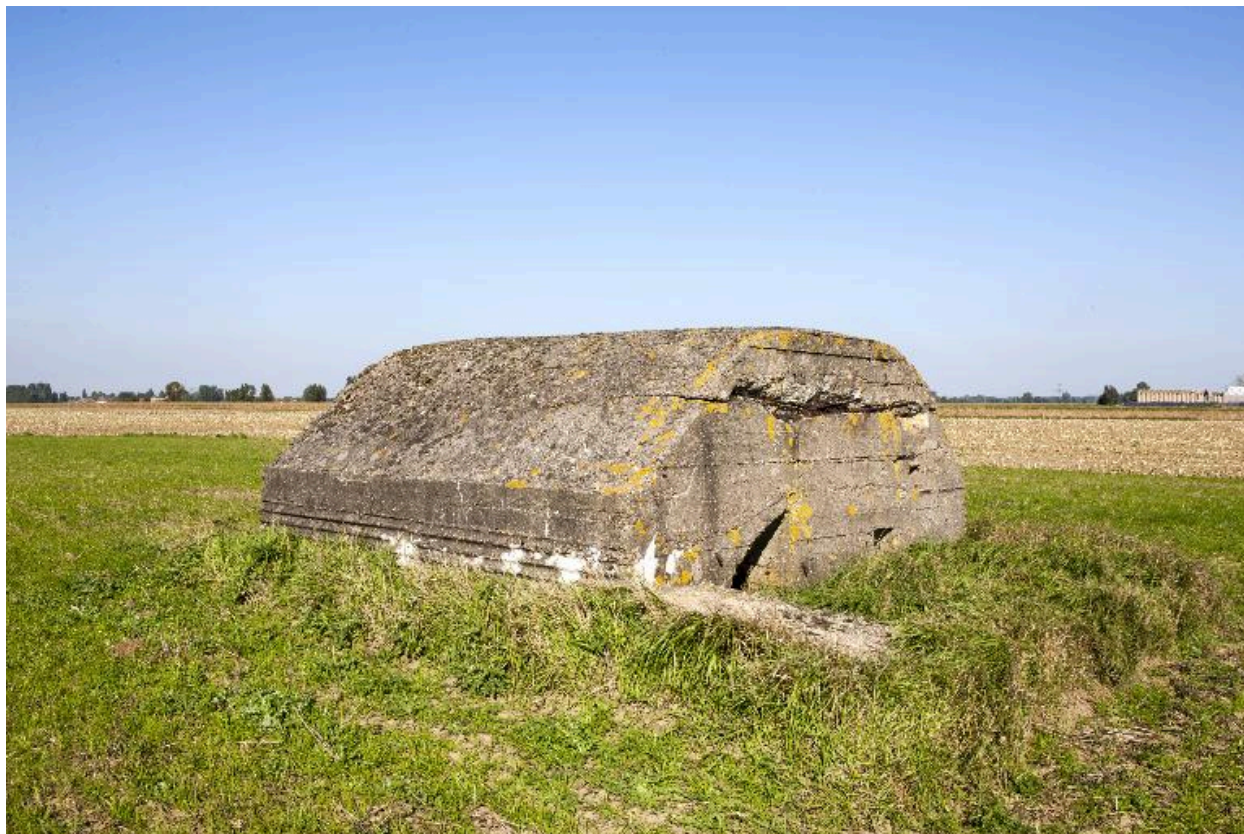
vue de trois-quarts vers le nord-est
