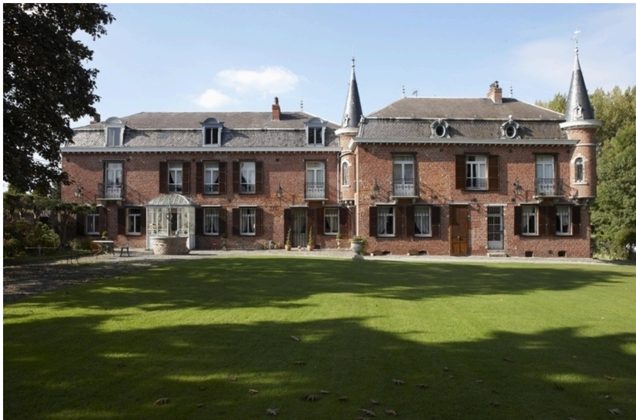
Vue générale depuis le parc.
