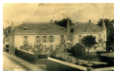
Vue générale, après les transformations des années 1890.
