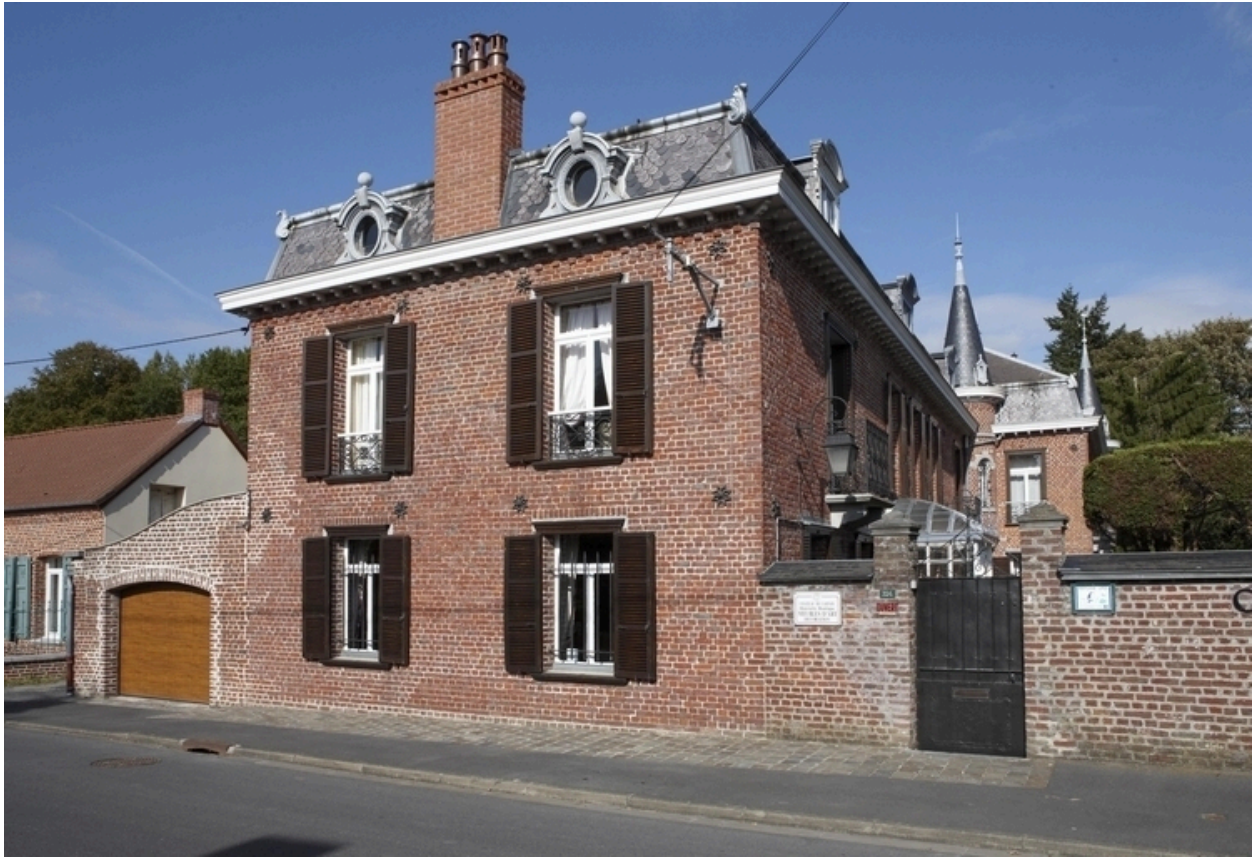
Vue de l'élévation sur rue.
