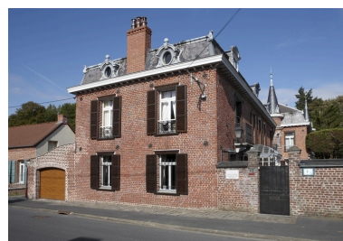
Vue de l'élévation sur rue. Phot. Pierre Thibaut IVR31_20095903214NUCA
