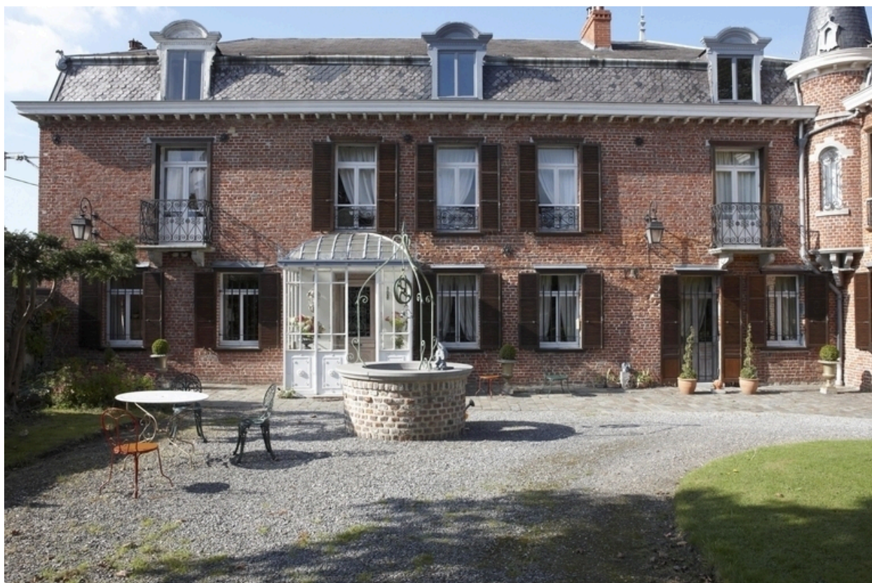
Vue du bâtiment surélevé.
