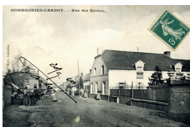
Vue du pignon de la demeure, avant les transformations des années 1890.
