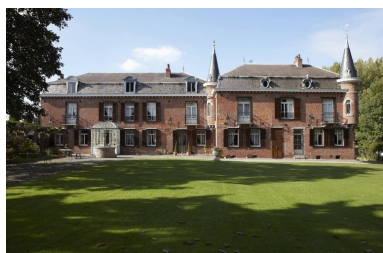
Vue générale depuis le parc. Phot. Pierre Thibaut IVR31_20095903210NUCA
