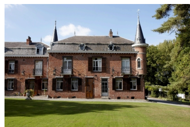
Vue du second bâtiment, rajouté dans les années 1890. Phot. Pierre Thibaut IVR31_20095903212NUCA
