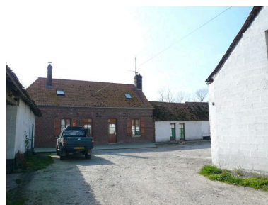
Vue du logis en fond de cour. Phot. Inès Guérin IVR22_20078005721NUCA
