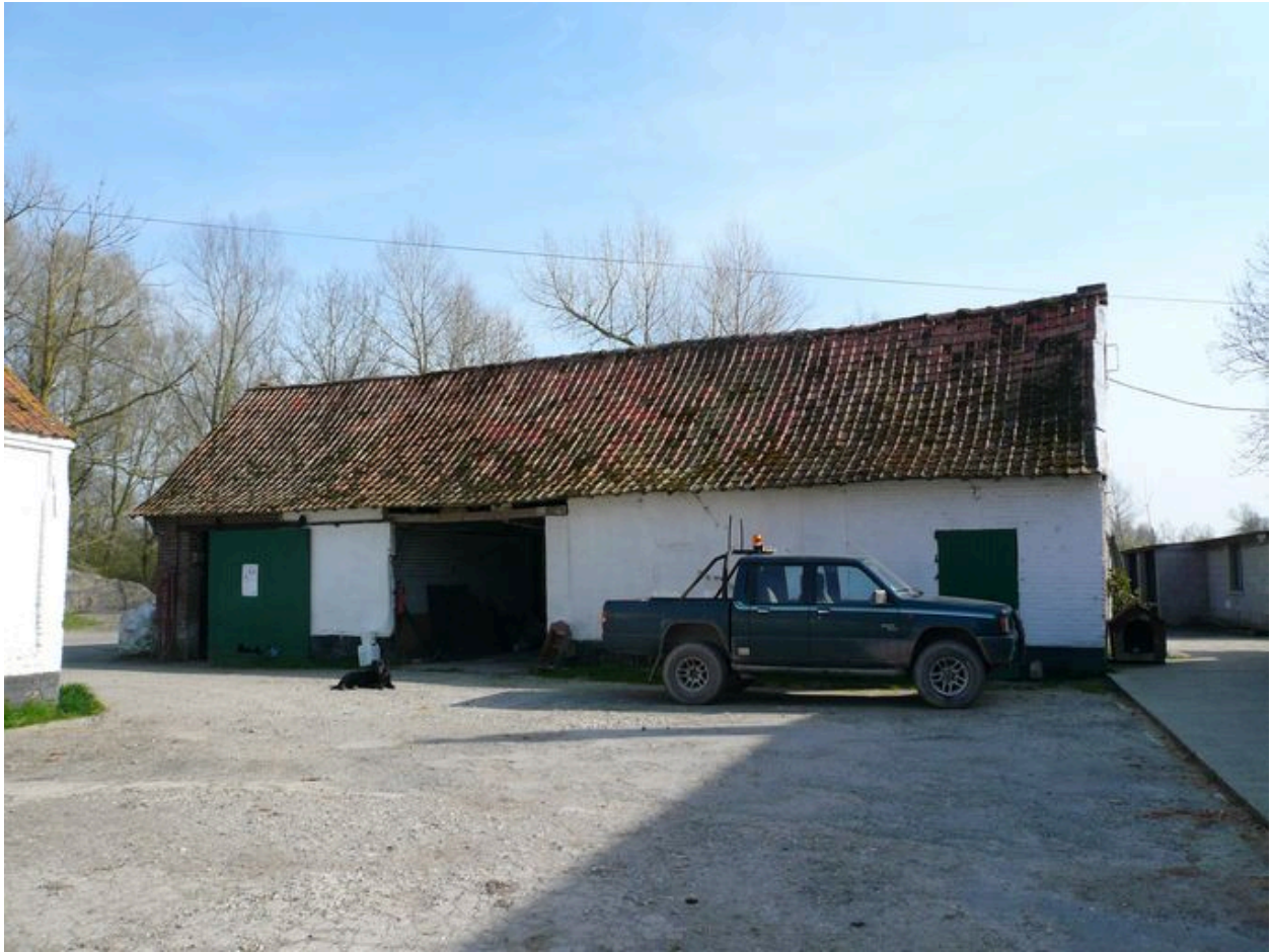
Vue de la grange depuis la cour.
