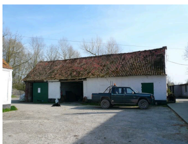
Vue de la grange depuis la cour. Phot. Inès Guérin IVR22_20078005720NUCA
