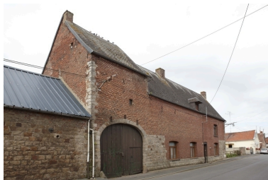
Vue du pigeonier-porche et du logis. Phot. Pierre Thibaut IVR31_20095902672NUCA
