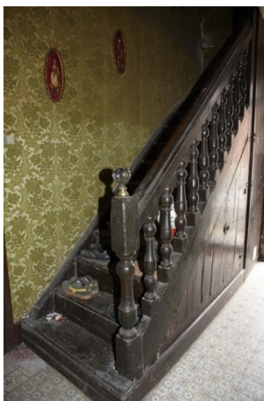
Détail du départ de l'escalier du logis. Phot. Pierre Thibaut IVR31_20095902721NUCA
