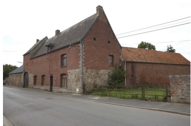
Vue générale de l'élévation sur rue depuis le nord-ouest. Phot. Pierre Thibaut IVR31_20095902676NUCA
