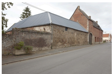
Vue générale de l'élévation sur rue depuis le sud-est. Phot. Pierre Thibaut IVR31_20095902671NUCA
