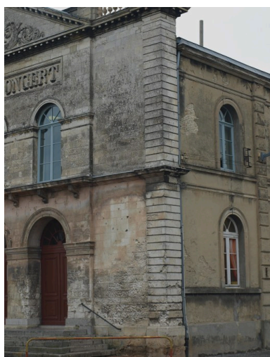
Détail : traitement de l'angle de jonction entre la façade principale et la façade latérale sud. Phot. Bruno Decrock IVR31_20106202279NUCA
