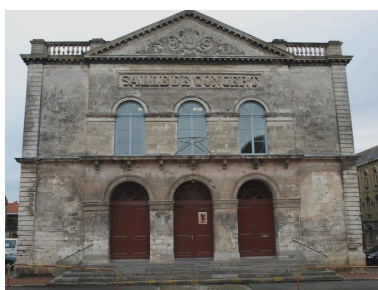
Façade principale : vue de face. Phot. Bruno Decrock IVR31_20106202274NUCA
