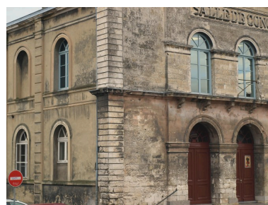
Détail : traitement de l'angle de jonction entre la façade principale et la façade latérale nord. Phot. Bruno Decrock IVR31_20106202273NUCA
