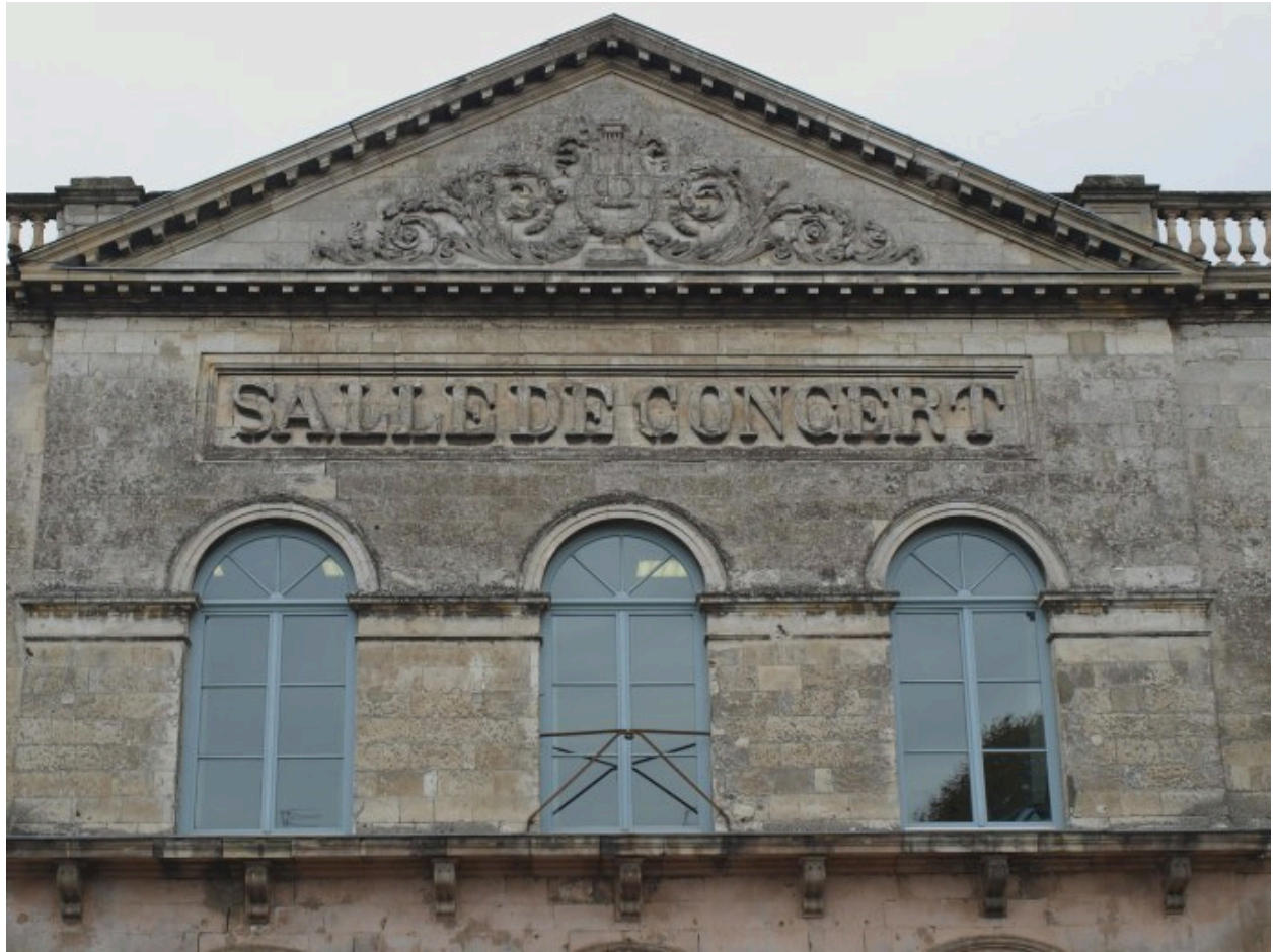
Façade principale, détail : avant-corps central, étage et fronton.
