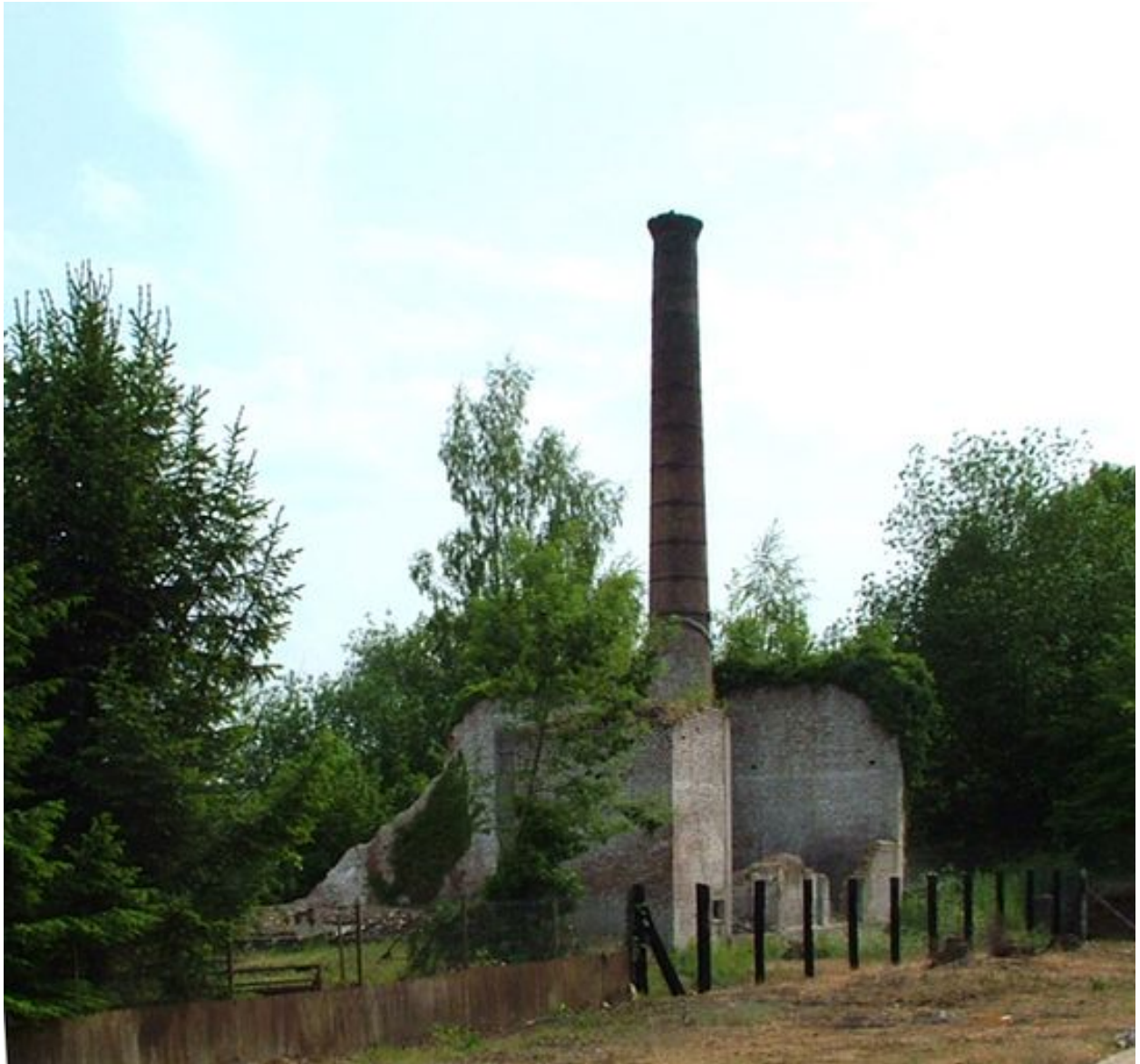
Vue depuis la voie ferrée.
