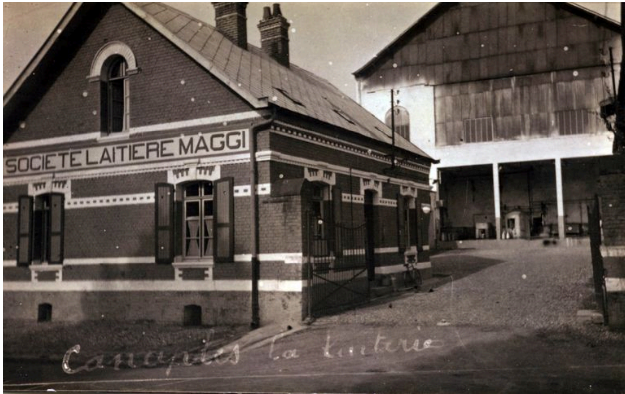
Vue partielle depuis la rue, 2e quart du 20e siècle (coll. part.).
