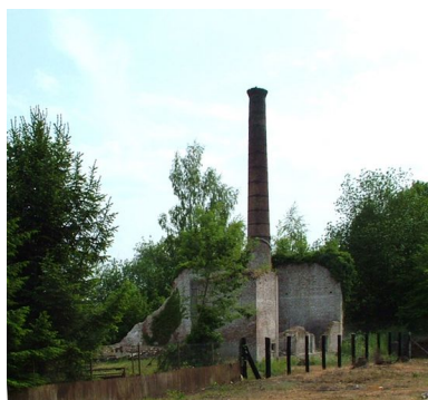
Vue depuis la voie ferrée. Phot. Frédéric Fournis IVR22_20108001359NUCA
