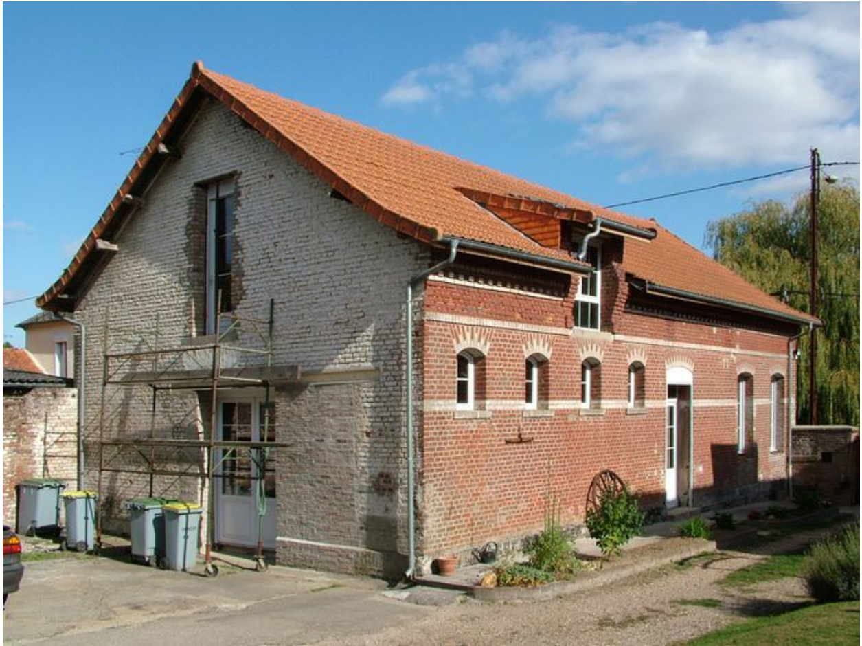
Ancienne écurie en bordure de cour.
