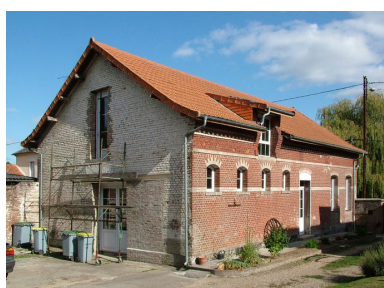
Ancienne écurie en bordure de cour. Phot. Frédéric Fournis IVR22_20098005509NUCA
