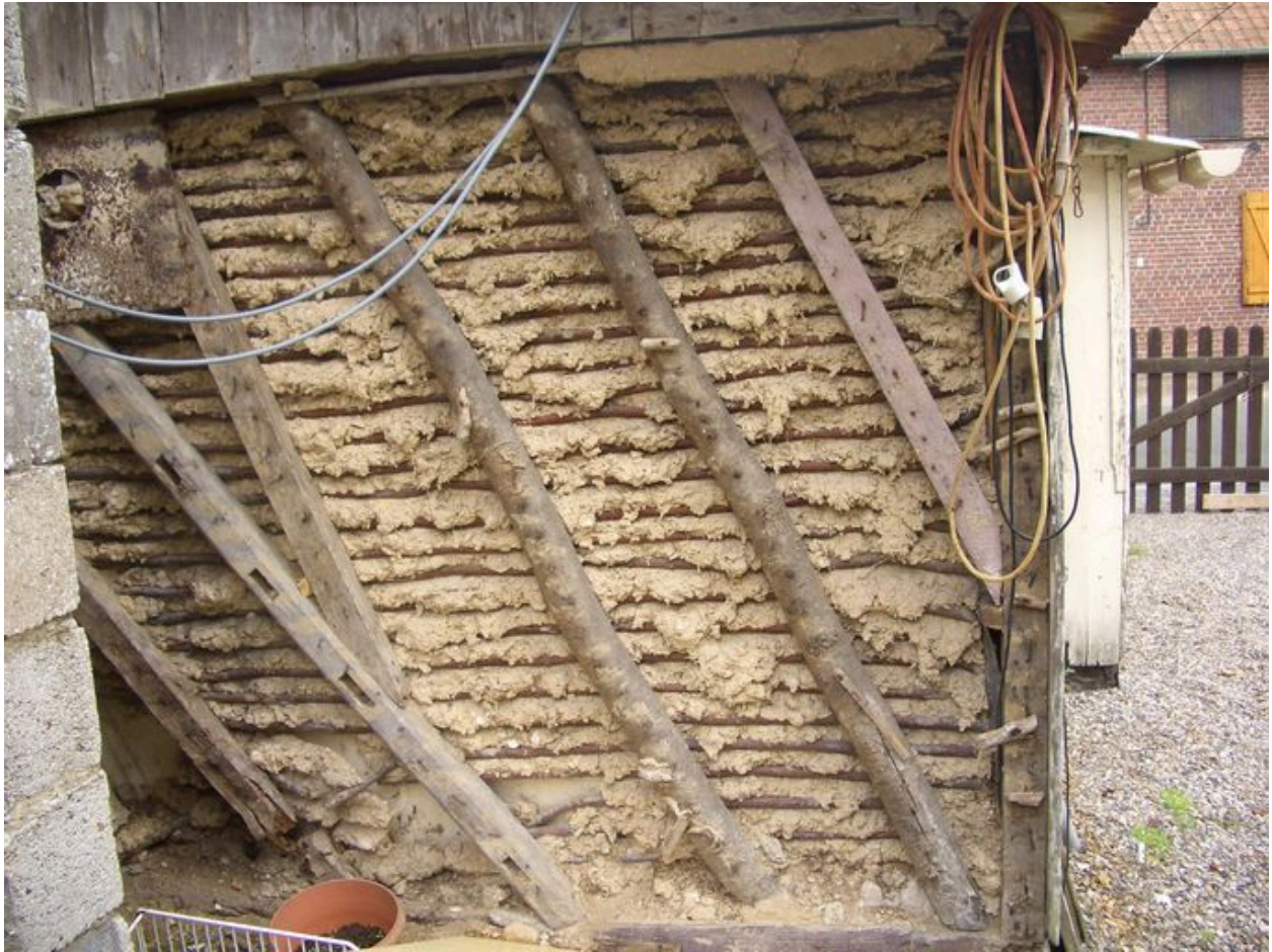
Vue détaillée de la maçonnerie de l'atelier en torchis et pans de bois.
