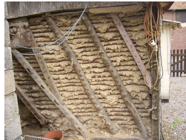
Vue détaillée de la maçonnerie de l'atelier en torchis et pans de bois. Phot. Inès Guérin IVR22_20078005132NUCA
