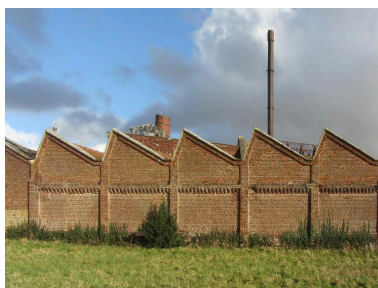
Pignons ouest en sheds des ateliers d'apprêts.
