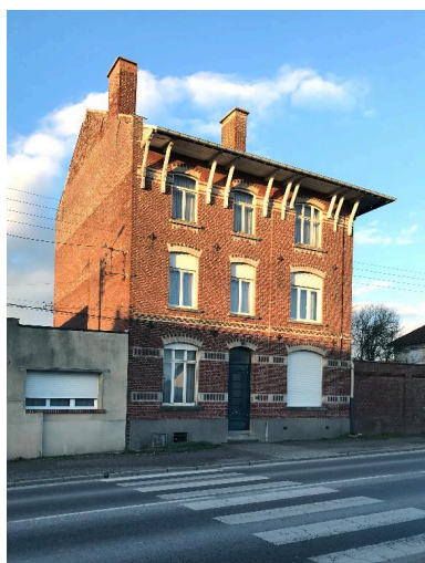
Façade sur rue du logement de directeur (23, rue d'Amiens)
