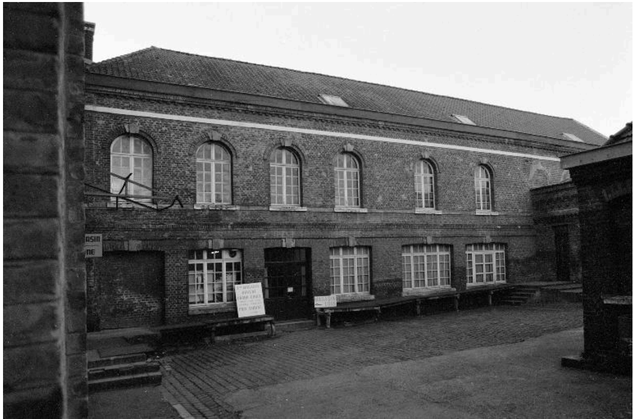
Élévation sur cour de l'atelier de pliage.
