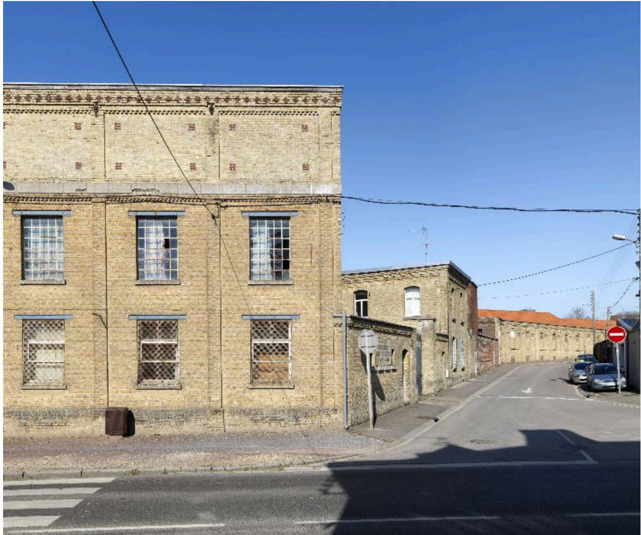
Détail des façades d'ateliers donnant sur la rue Delacour-Rousseau et vue partielle des bureaux.
