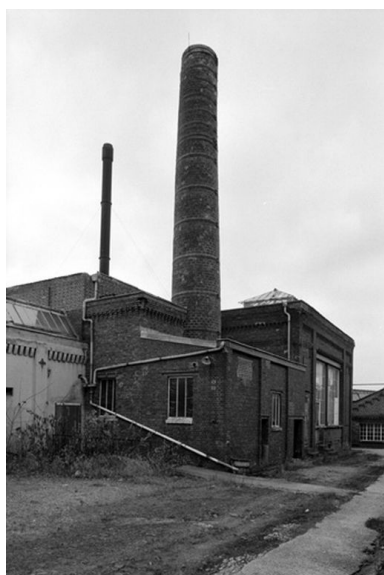
Chaufferie, salle des machines et cheminée d'usine, flanc nord-est en 1987. Phot. Benoît Dufournier IVR22_19878000433Z
