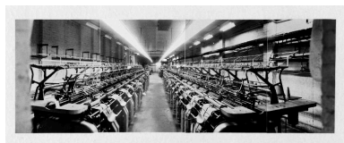
Atelier de fabrication dit "les colonnes" (archives privées). Phot. Philippot Jacques IVR22_19888000456XB
