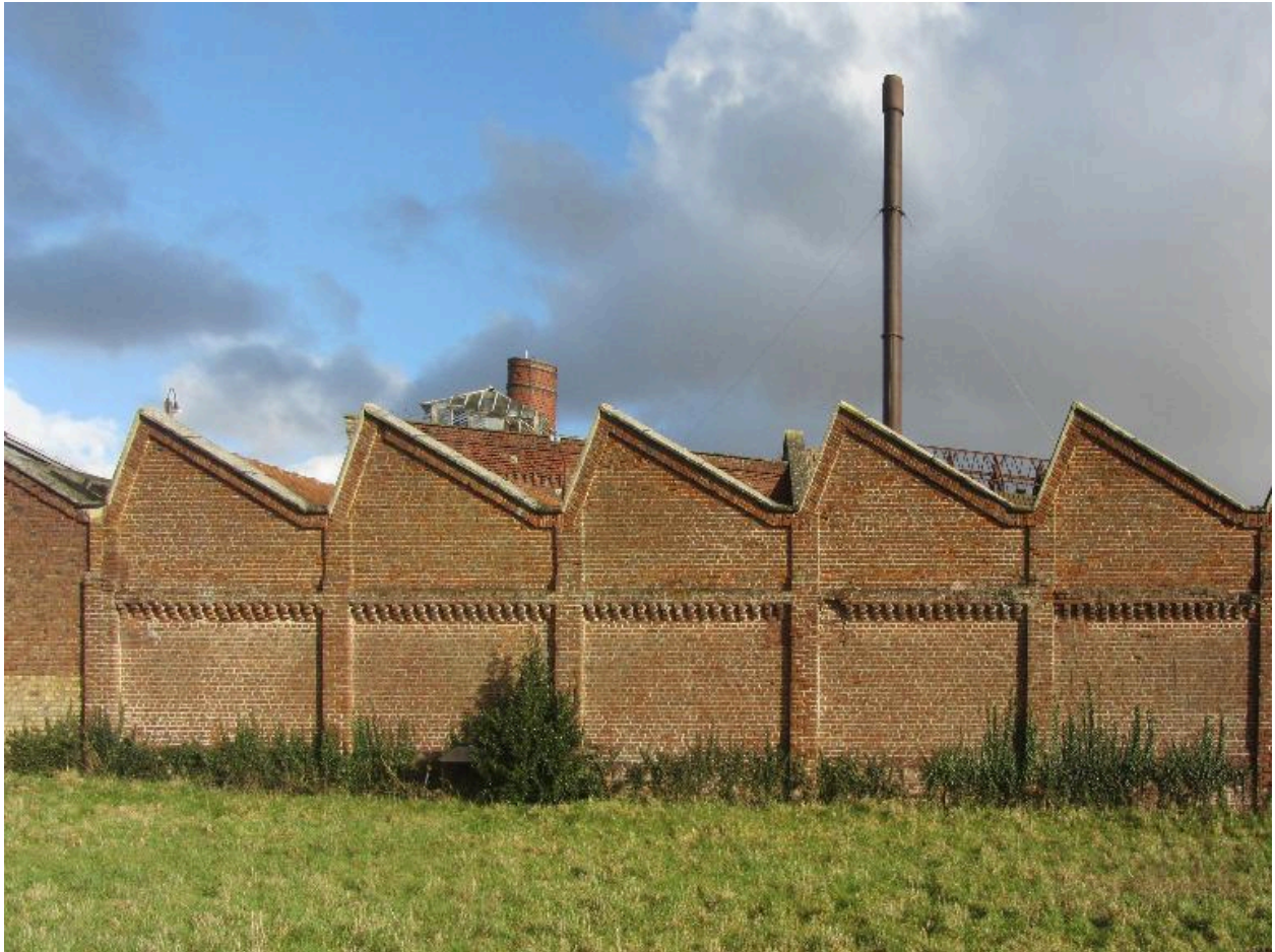
Pignons ouest en sheds des ateliers d'apprêts.
