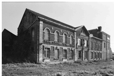
Vue générale de l'atelier de pliage depuis le nord-ouest. Phot. Benoît Dufournier IVR22_19878000190Z
