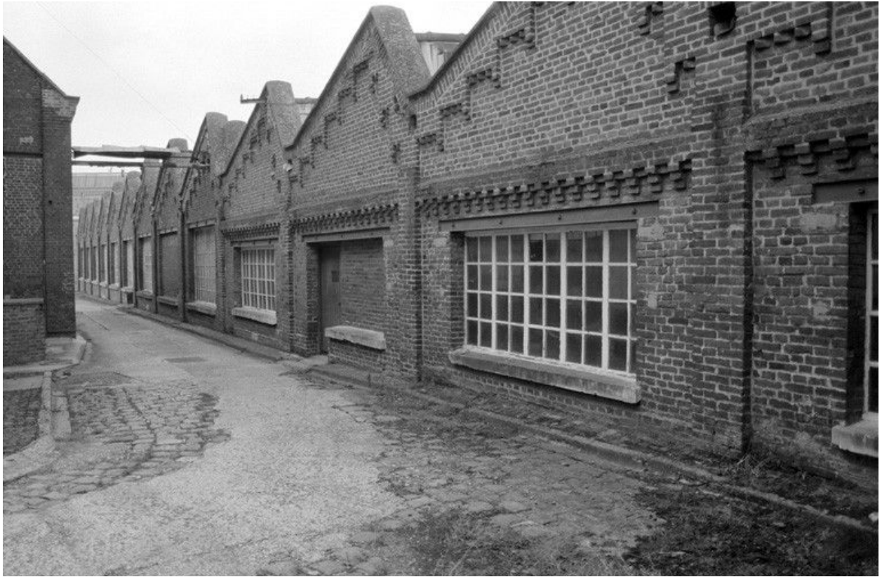
Atelier de fabrication, flanc est.
