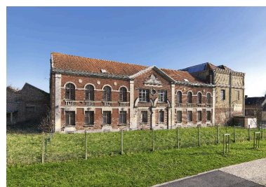
Façade ouest de l'atelier de pliage. Phot. Thierry Lefébure IVR32_20168000073NUC2A
