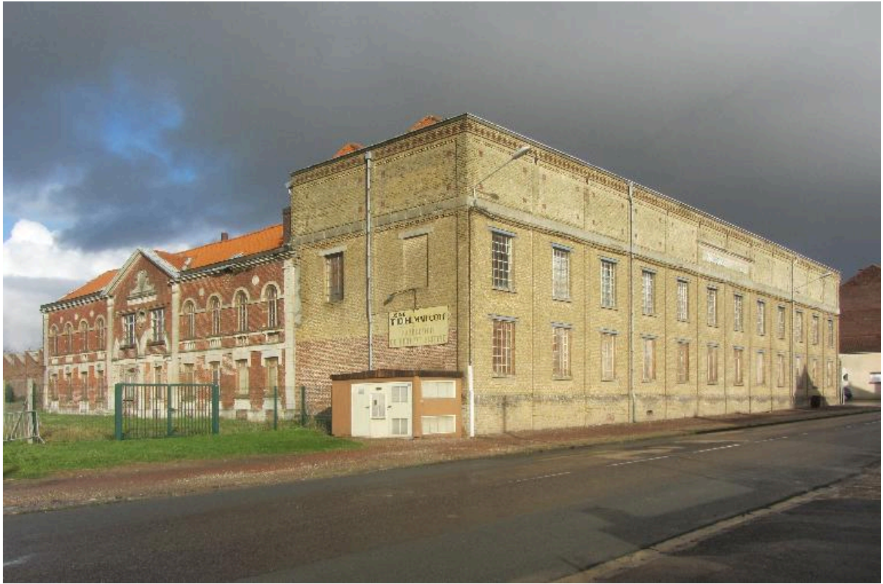
Vue générale depuis la route nationale.
