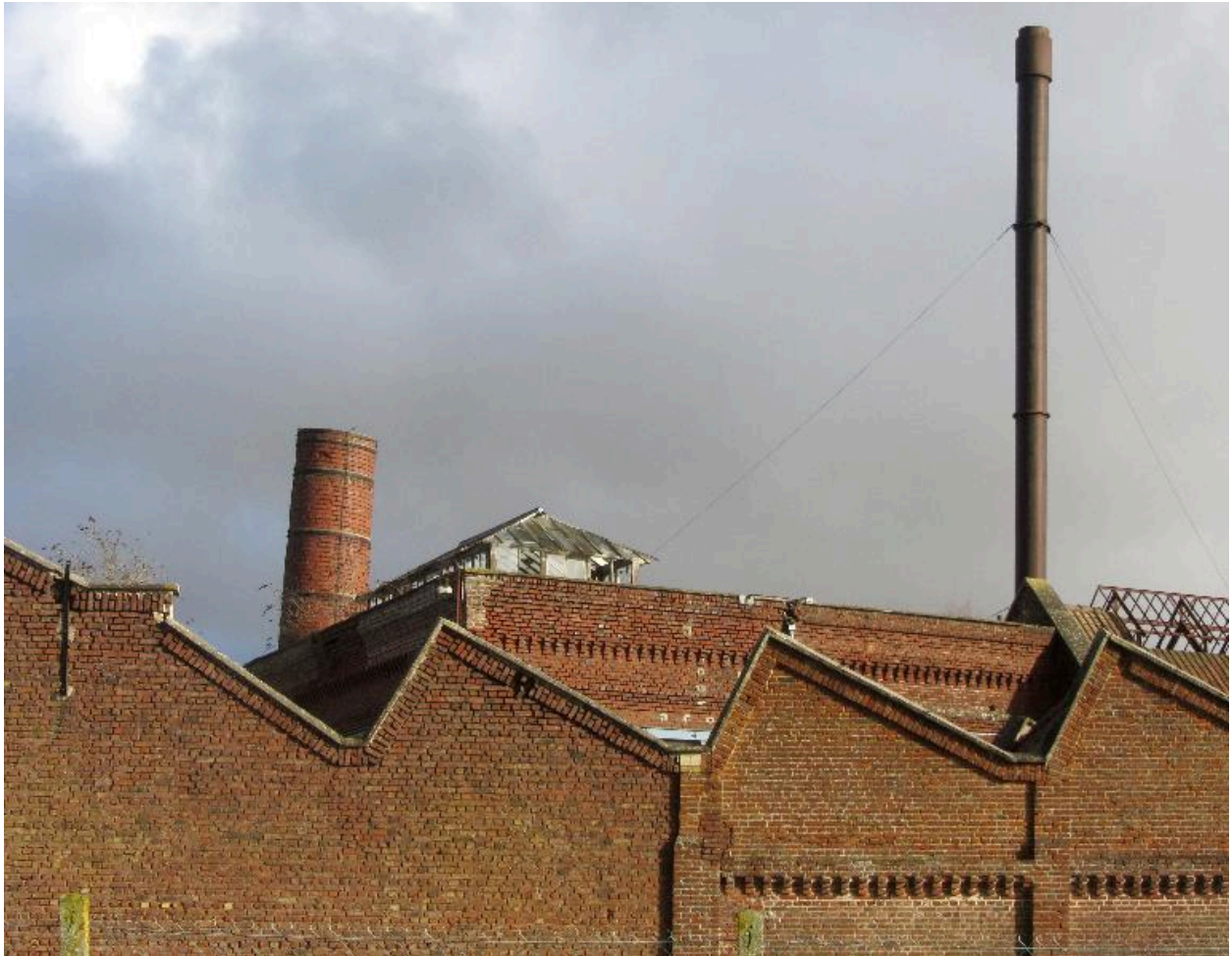
Détail des pignons en sheds et des cheminées de l'usine.
