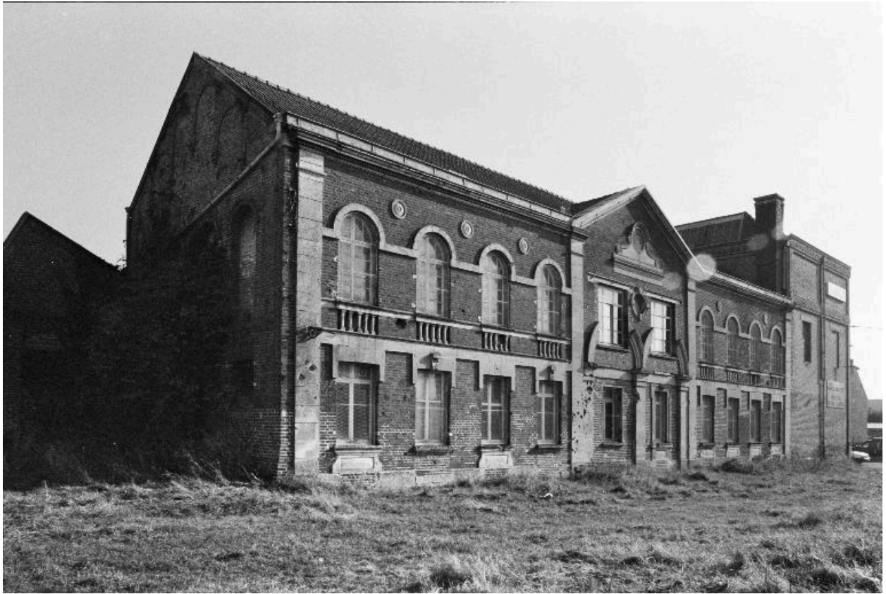
Vue générale de l'atelier de pliage depuis le nord-ouest.
