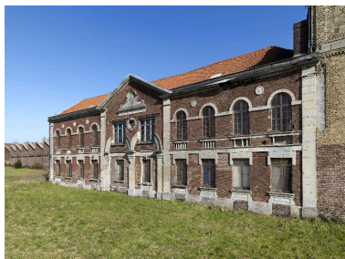
Façade ouest de l'atelier de pliage. Phot. Thierry Lefébure IVR32_20168000071NUC2A
