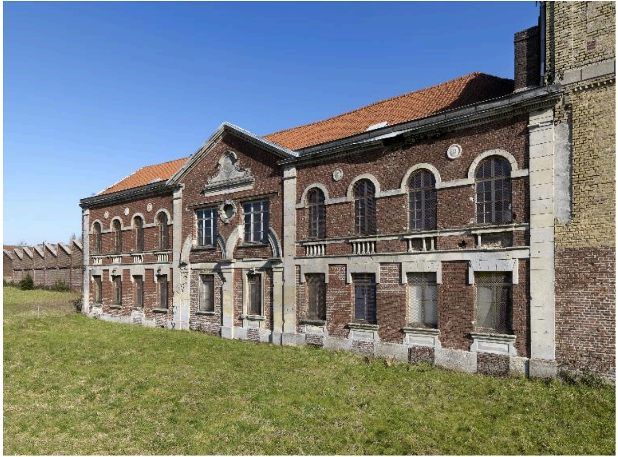
Façade ouest de l'atelier de pliage.
