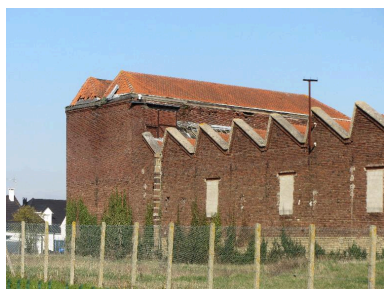
Détail des ateliers en shed de la teinturerie et de l'atelier de lissage. Phot. Bertrand Fournier IVR32_20168005124NUCA
