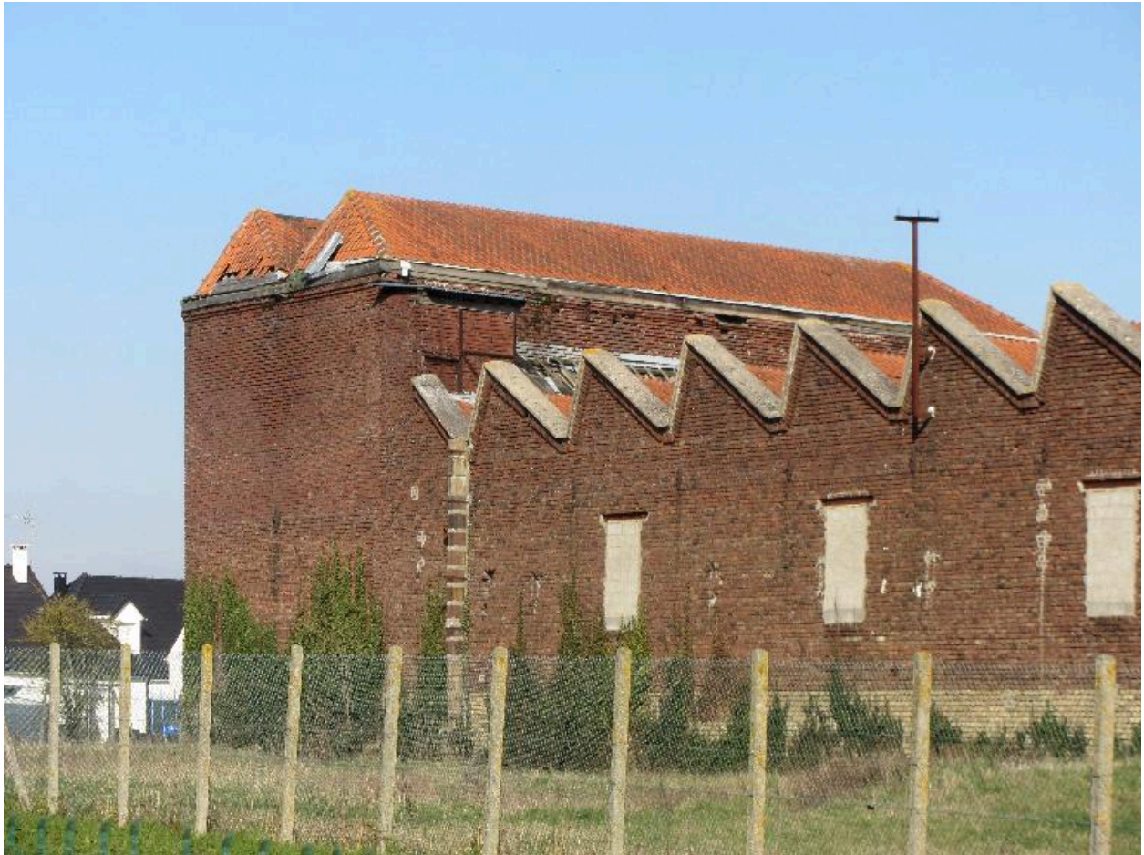
Détail des ateliers en shed de la teinturerie et de l'atelier de lissage.
