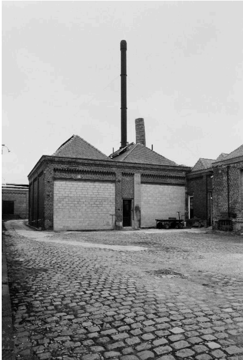
Chaufferie, flanc sud-est en 1987.
