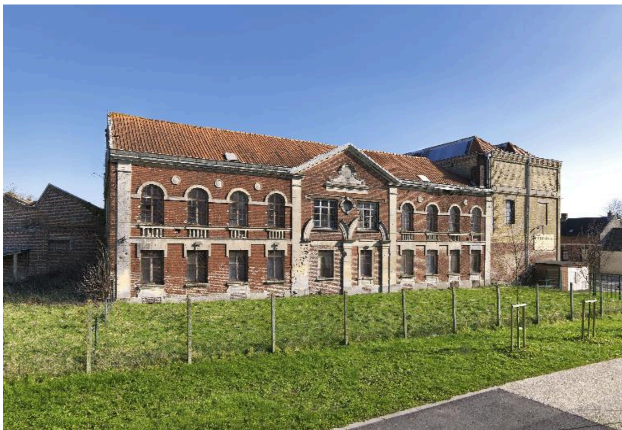
Façade ouest de l'atelier de pliage.
