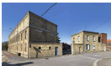
Vue d'ensemble de l'entrée de l'usine et des bureaux. Phot. Thierry Lefébure IVR32_20168000067NUC2AQ
