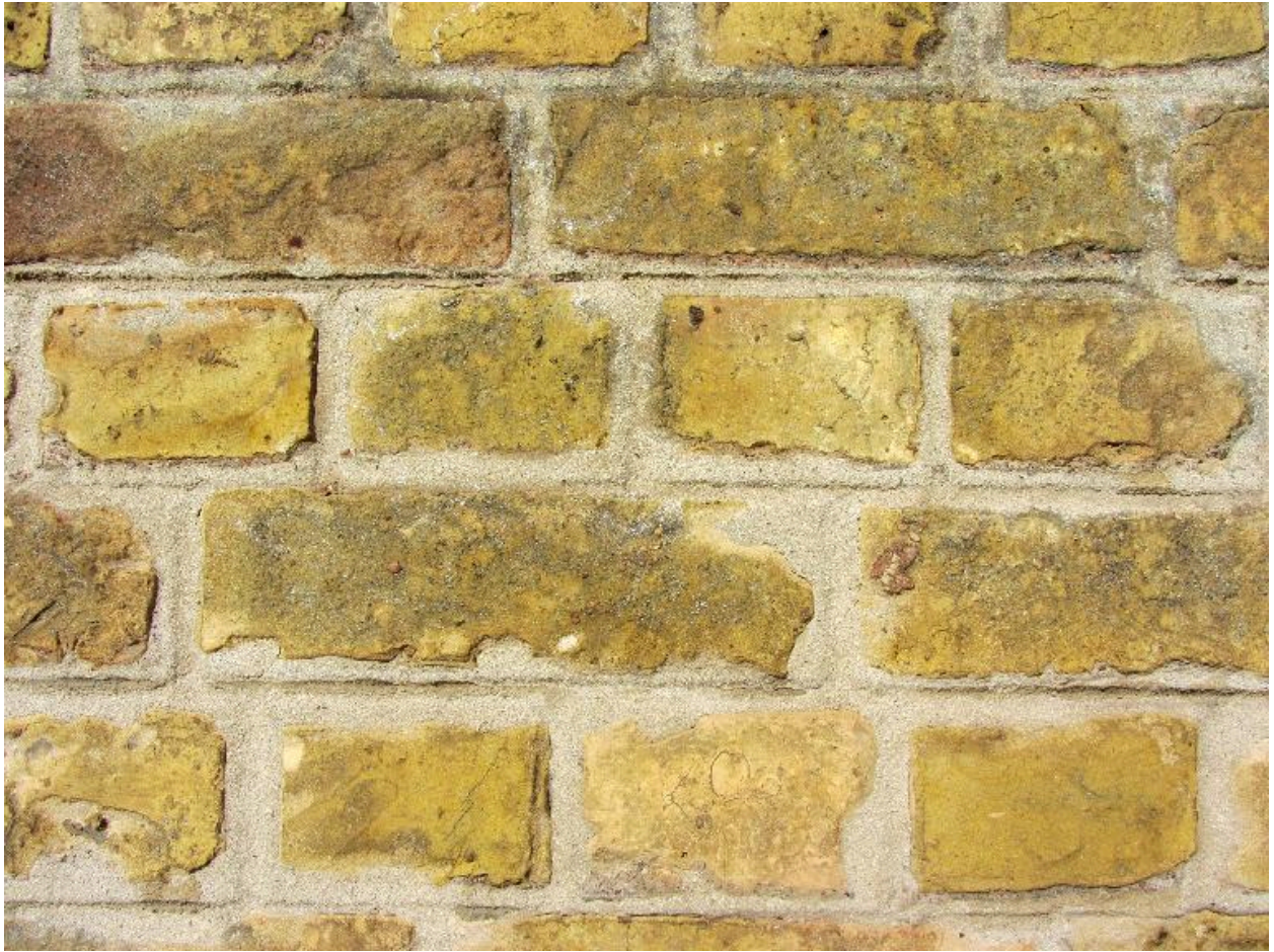
Détail de l'appareil de briques ocre des bureaux.
