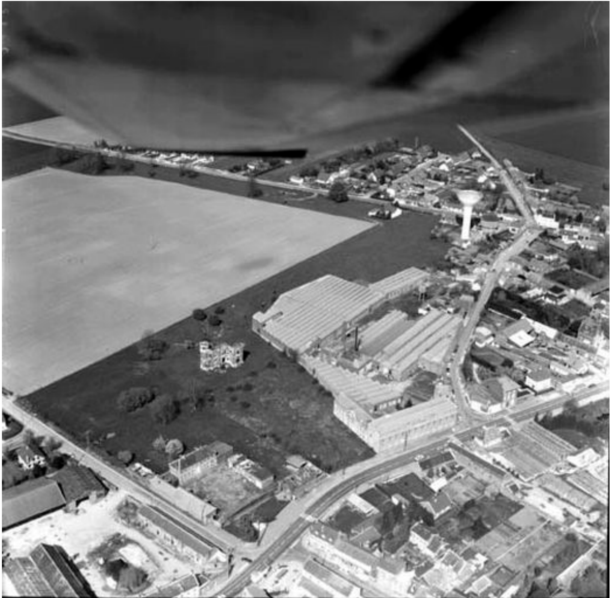
Vue aérienne, flanc sud-ouest.
