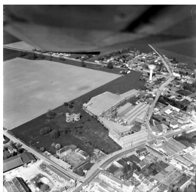
Vue aérienne, flanc sud-ouest. Phot. Phot'R IVR22_19888001191P
