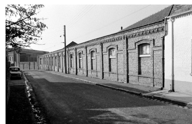
Façade est sur rue des ateliers de tricottage, dit des métiers Saxons, vue partielle. Phot. Benoît Dufournier IVR22_19878000185Z
