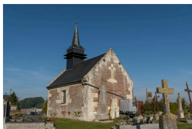
Vue de la façade occidentale de la chapelle Saint- Martin depuis le sud-est. Phot. Marc Kérignard IVR32_20216001076NUCA
