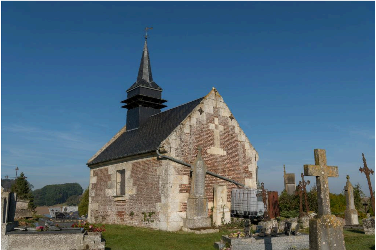
Vue de la façade occidentale de la chapelle Saint-Martin depuis le sud-est.
