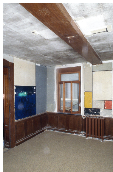
Pièce décorée par Félix Del Marle (1889-1952) : vue générale des murs 1A et 4 en cours de restauration et les sondages du plafond (août 2001). Phot. Thierry Petitberghien IVR31_20015901742ZA
