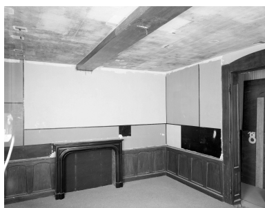
Pièce décorée par Félix Del Marle (1889-1952) : vue générale des murs 2B, 2A et 1 B en cours de restauration (août 2001). Phot. Thierry Petitberghien IVR31_20015901726V
