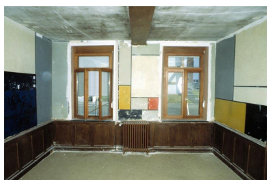
Pièce décorée par Félix Del Marle (1889-1952) : vue générale du mur 4 en cours de restauration (août 2001). Phot. Thierry Petitberghien IVR31_20015901743ZA
