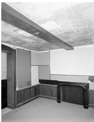
Pièce décorée par Félix Del Marle (1889-1952) : vue générale des murs 3B et 2B en cours de restauration et les sondages du plafond (août 2001). Phot. Thierry Petitberghien IVR31_20015901728V
