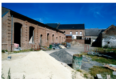
Vue générale de l'aile occidentale de l'ancienne brasserie-malterie, depuis la cour, en cours de restauration (août 2001). Phot. Thierry Petitberghien IVR31_20015901746ZA
