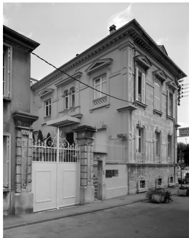
Vue de la façade sur cour et sur la rue Lefèvre-Maugras. Phot. Thierry Lefébure IVR22_19960200492V
