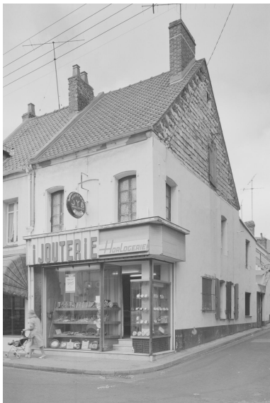
Vue générale de la maison de commerce depuis la rue. Phot. Philippe Caudroit IVR31_19836200256X
