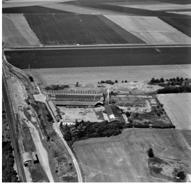
Vue aérienne, flanc est. Phot. Phot'R IVR22_19888001244P
