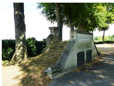
Le dépositoire, vue de trois-quart. Phot. Isabelle Barbedor IVR32_20178005137NUCA
