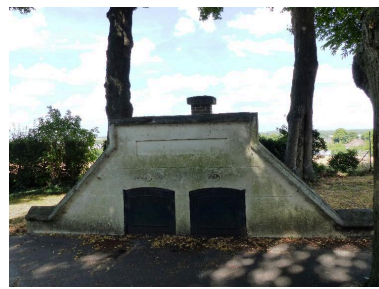
Le dépositoire. Vue de face. Phot. Isabelle Barbedor IVR32_20178005136NUCA
