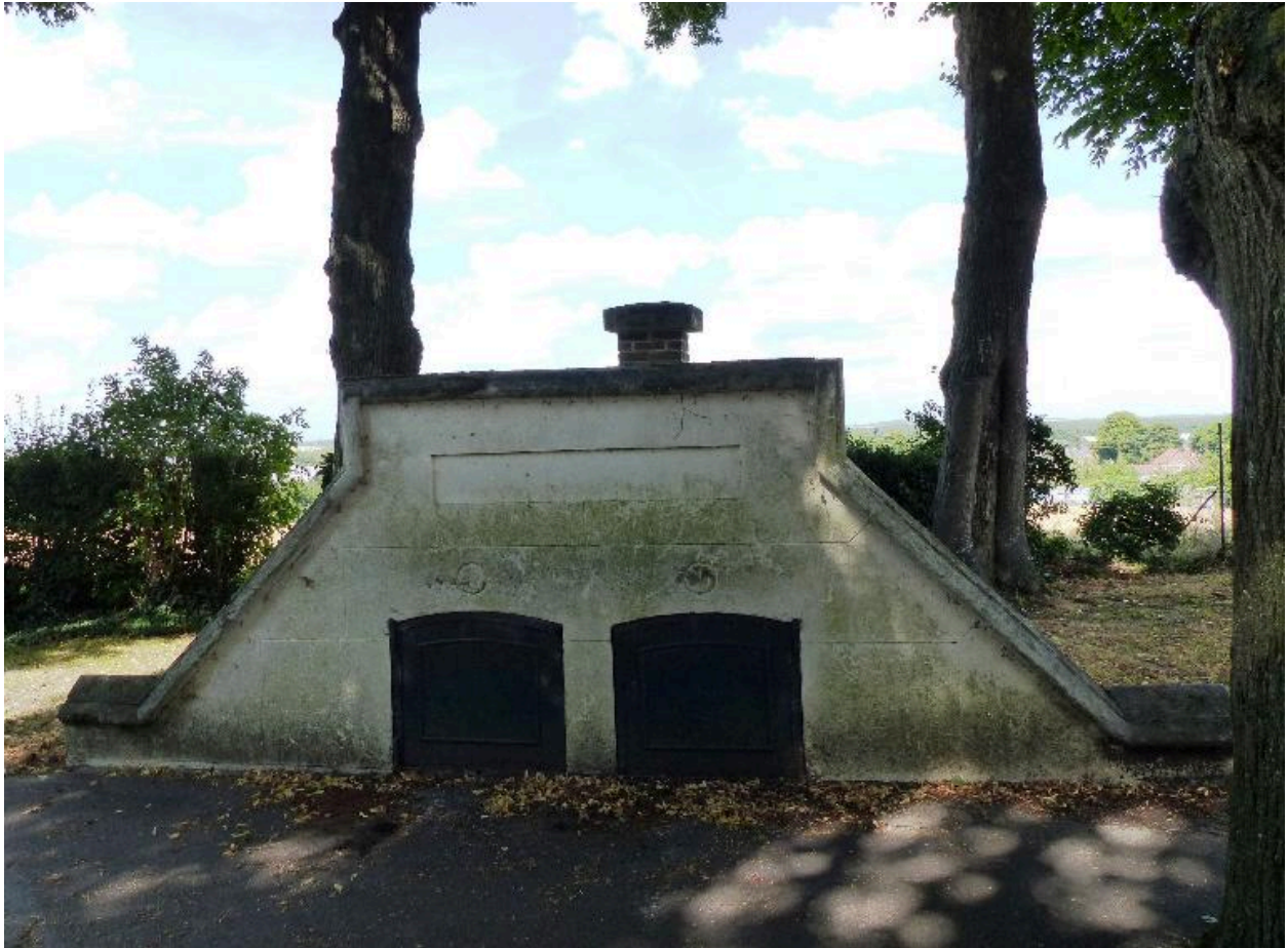
Le dépositoire. Vue de face.
