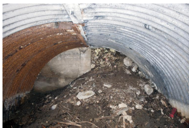
Casemate A. Salle perpendiculaire au couloir. Au fond : accès au poste de mitrailleuse (?) Phot. Pierre Thibaut IVR32_20165900989NUCA
