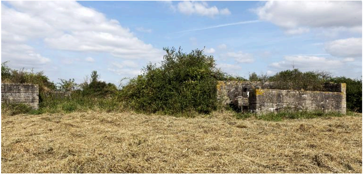
A gauche, la casemate A (tronquée), à droite, la casemate B.
