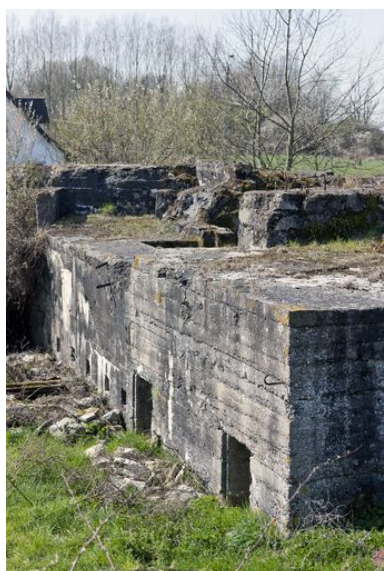
Casemate A. Depuis le couvrement de la casemate B, vers l'ouest Phot. Jean-Marc Ramette IVR31_20145904213NUCA
