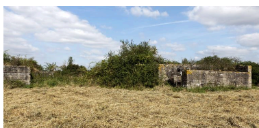
A gauche, la casemate A (tronquée), à droite, la casemate B. Phot. Jean-Marc Ramette IVR31_20145904224NUCA
