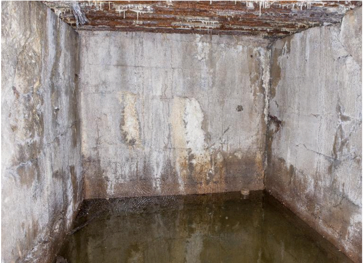
Casemate A. Arrière salle.
