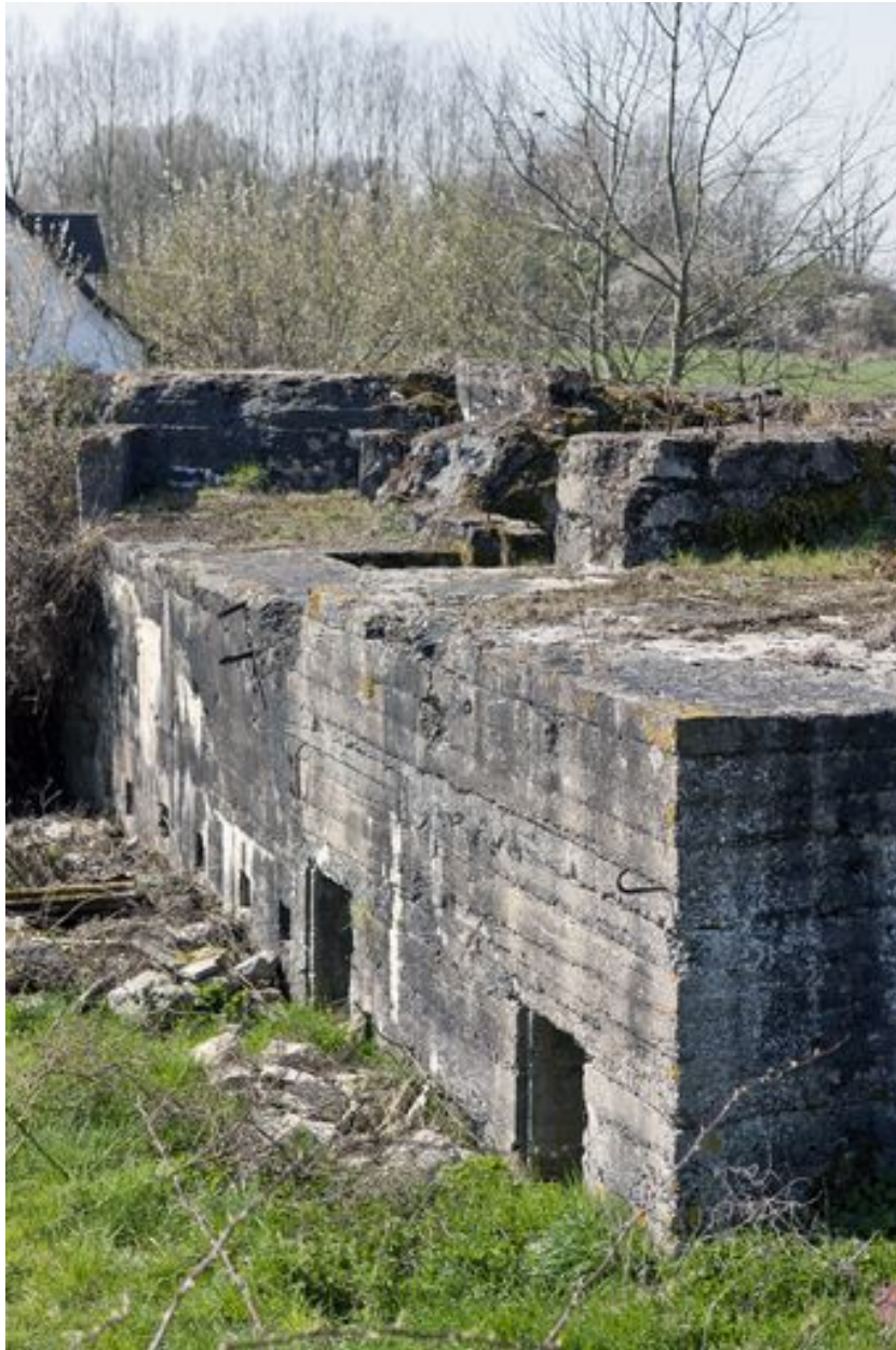
Casemate A. Depuis le couverture de la casemate B, vers l'ouest
