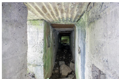
Casemate A, couloir de distribution intérieure, vers le sud-ouest. Phot. Pierre Thibaut IVR32_20165900988NUCA
