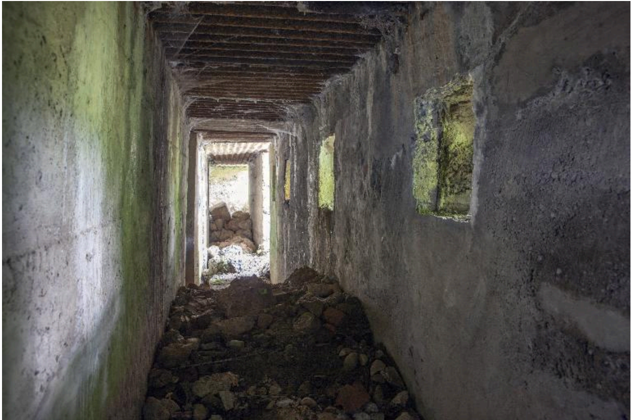
Casemate A, couloir de distribution intérieure, vers le nord-est. A droite, créneaux de fusillade.
