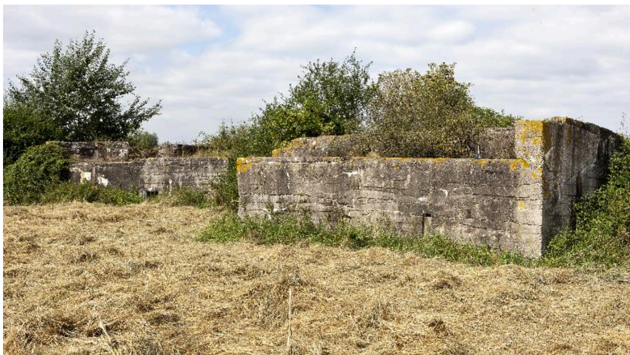
Casemate B, vers l'ouest, au premier plan. Dans le fond à gauche, la casemate A.
