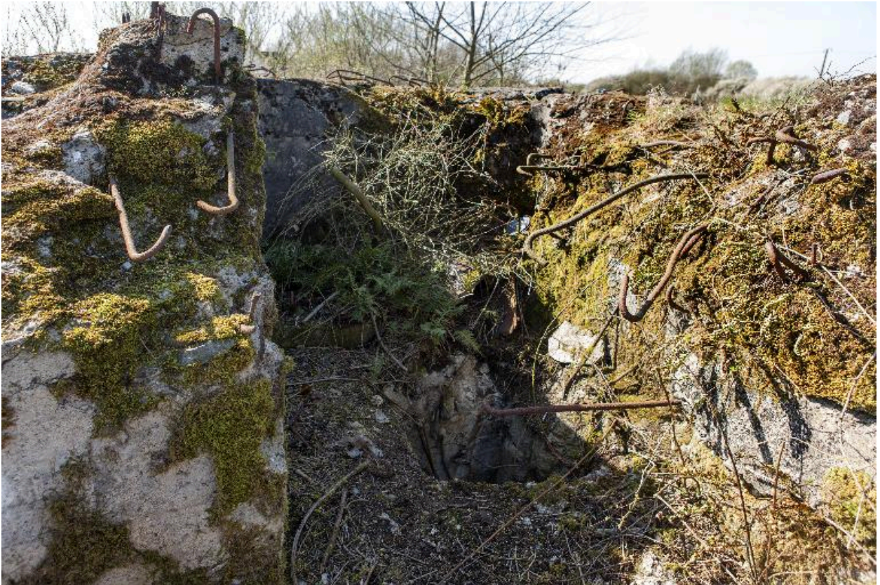
Casemate A. Depuis le couverture. Débouché de l'accès à la mitrailleuse
