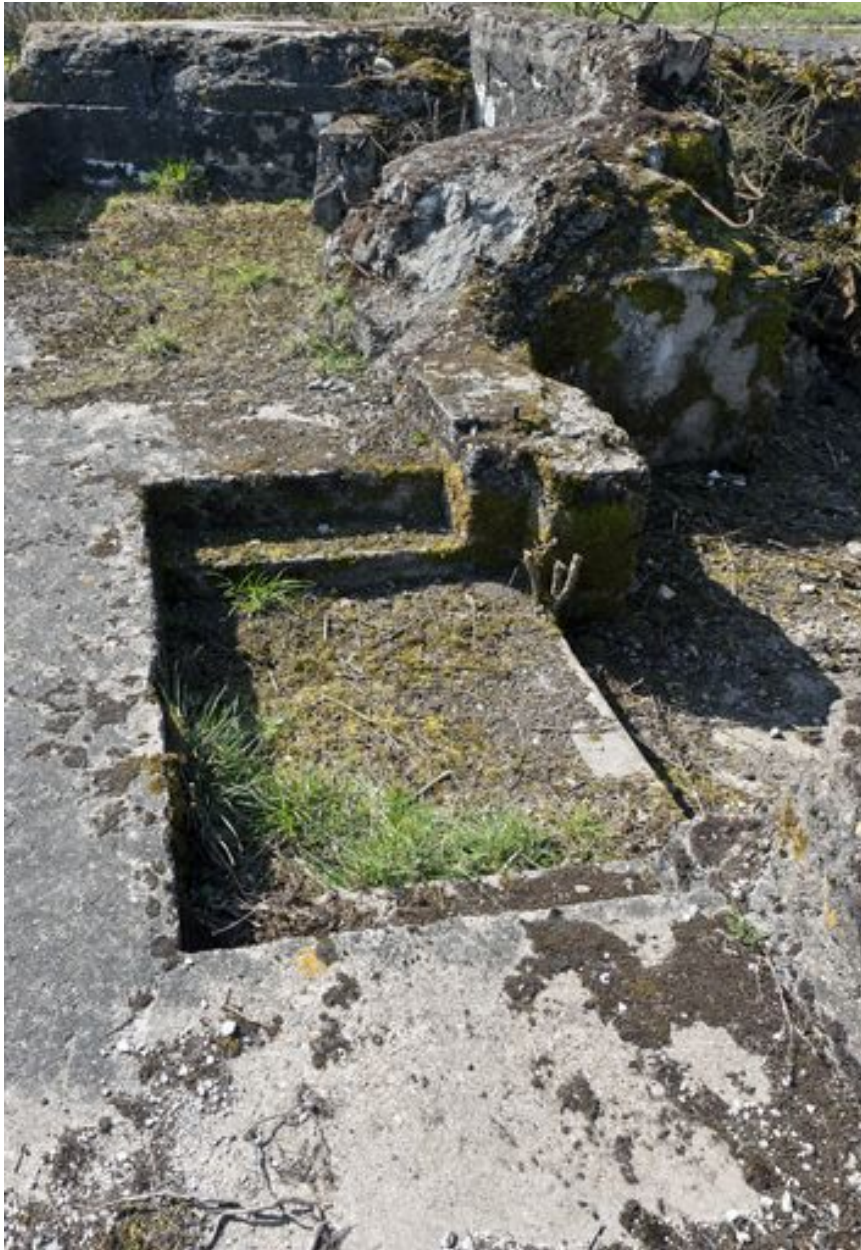
Casemate A. Depuis le couverture, vers le sud-ouest : degré rectangulaire rentrant attestant un étage aujourd'hui disparu
