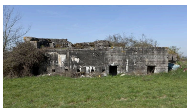
Casemate A : Vers le nord ouest Phot. Jean-Marc Ramette IVR31_20145904210NUCA
