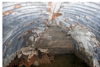
Casemate A. Salle perpendiculaire au couloir Phot. Pierre Thibaut IVR32_20165900987NUCA
