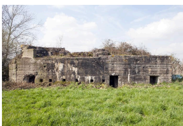
Casemate A : Vers le nord ouest Phot. Pierre Thibaut IVR32_20165900562NUCA
