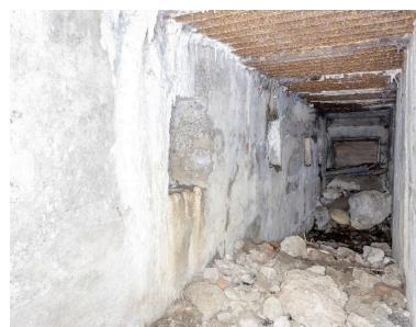
Casemate A, couloir de distribution intérieure, vers le sud-ouest. Phot. Pierre Thibaut IVR32_20165900559NUCA
