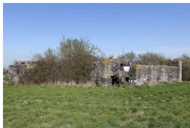
La casemate B. Vue générale vers le nord Phot. Jean-Marc Ramette IVR31_20145904211NUCA
