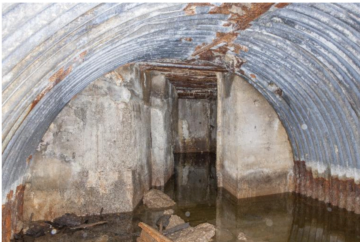
Casemate A. Salle perpendiculaire au couloir menant à une arrière salle
