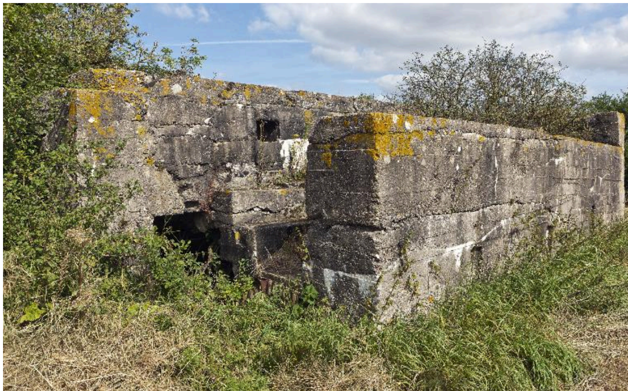
Casemate B: Elévation sud-est. Banquette d'Infanterie et mur pare-souffle
