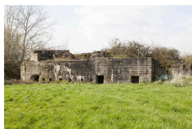
Casemate A : Vers le nord ouest Phot. Pierre Thibaut IVR32_20165900564NUCA
