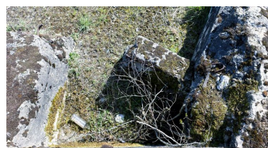
Casemate A. Depuis le mur sud- ouest et vers le bas, piécette attestant un étage aujourd'hui disparu Phot. Jean-Marc Ramette IVR31_20145904219NUCA
