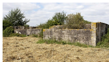
Casemate B, vers l'ouest, au premier plan. Dans le fond à gauche, la casemate A. Phot. Jean-Marc Ramette
