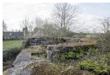
Casemate A: Dsepuis le couvrement, vers le sud-ouest Phot. Pierre Thibaut IVR32_20165900568NUCA
