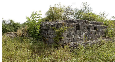
Casemate B: Vue vers l'est Phot. Jean-Marc Ramette IVR31_20145904345NUCA
