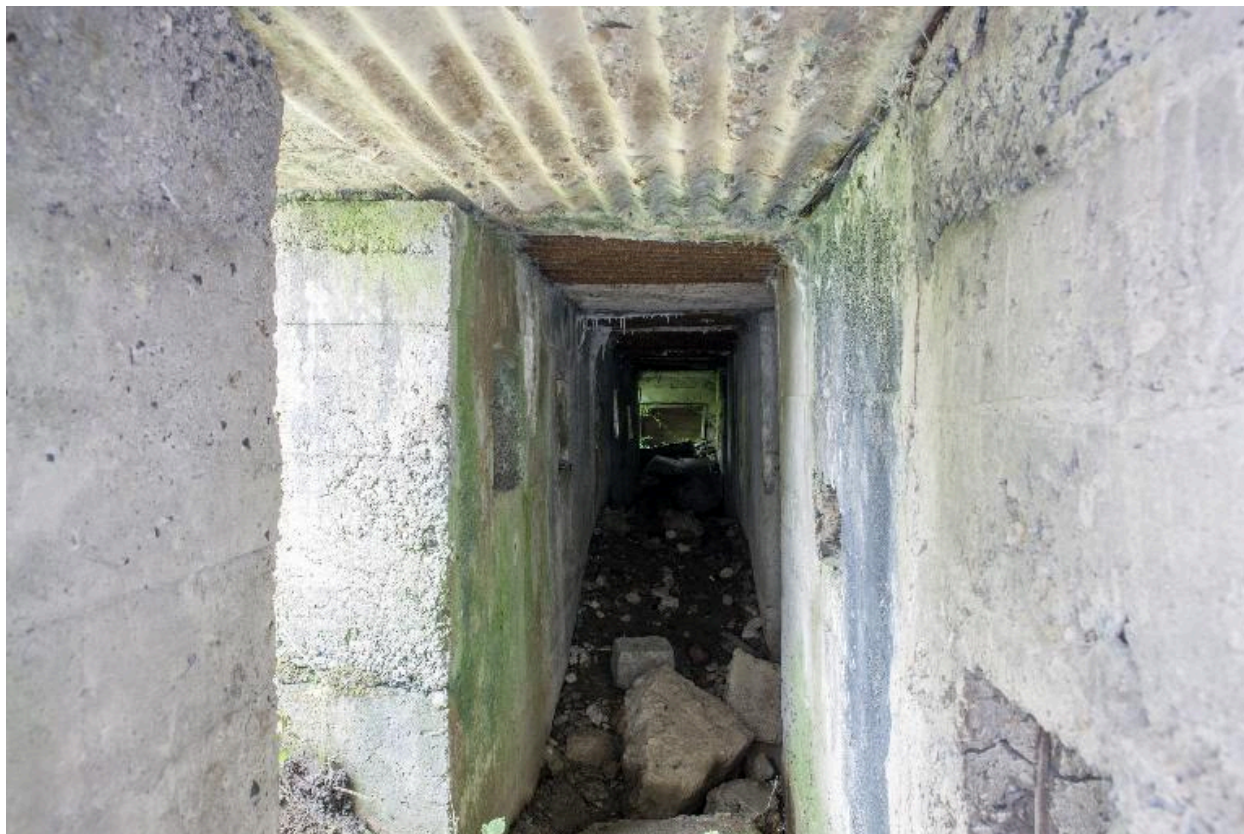
Casemate A, couloir de distribution intérieure, vers le sud-ouest.
