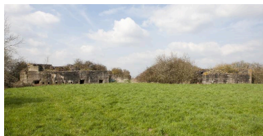
Vue d'ensemble vers le nord. A gauche, la casemate A, à droite, la casemate B. Phot. Jean-Marc Ramette IVR32_20165900563NUCA
