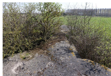
Casemate B : Depuis le couvrent, vers l'est mince passage et/ou banquette de tir reliant les deux parties de l'édifice Phot. Jean-Marc Ramette IVR31_20145904214NUCA
