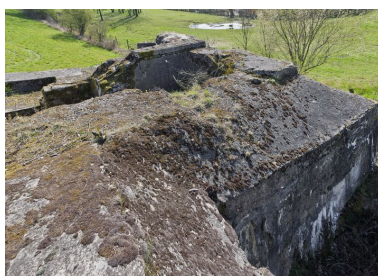
Casemate A. Depuis la position pour mitrailleuse, vers le sud Phot. Jean-Marc Ramette IVR31_20145904216NUCA
