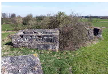
Casemate B. Vue générale vers nord-est, depuis la casemate A. Phot. Jean-Marc Ramette IVR31_20145904220NUCA
