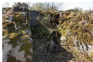
Casemate A. Depuis le couvrement. Débouché de l'accès à la mitrailleuse Phot. Jean-Marc Ramette IVR32_20175900081NUCA
