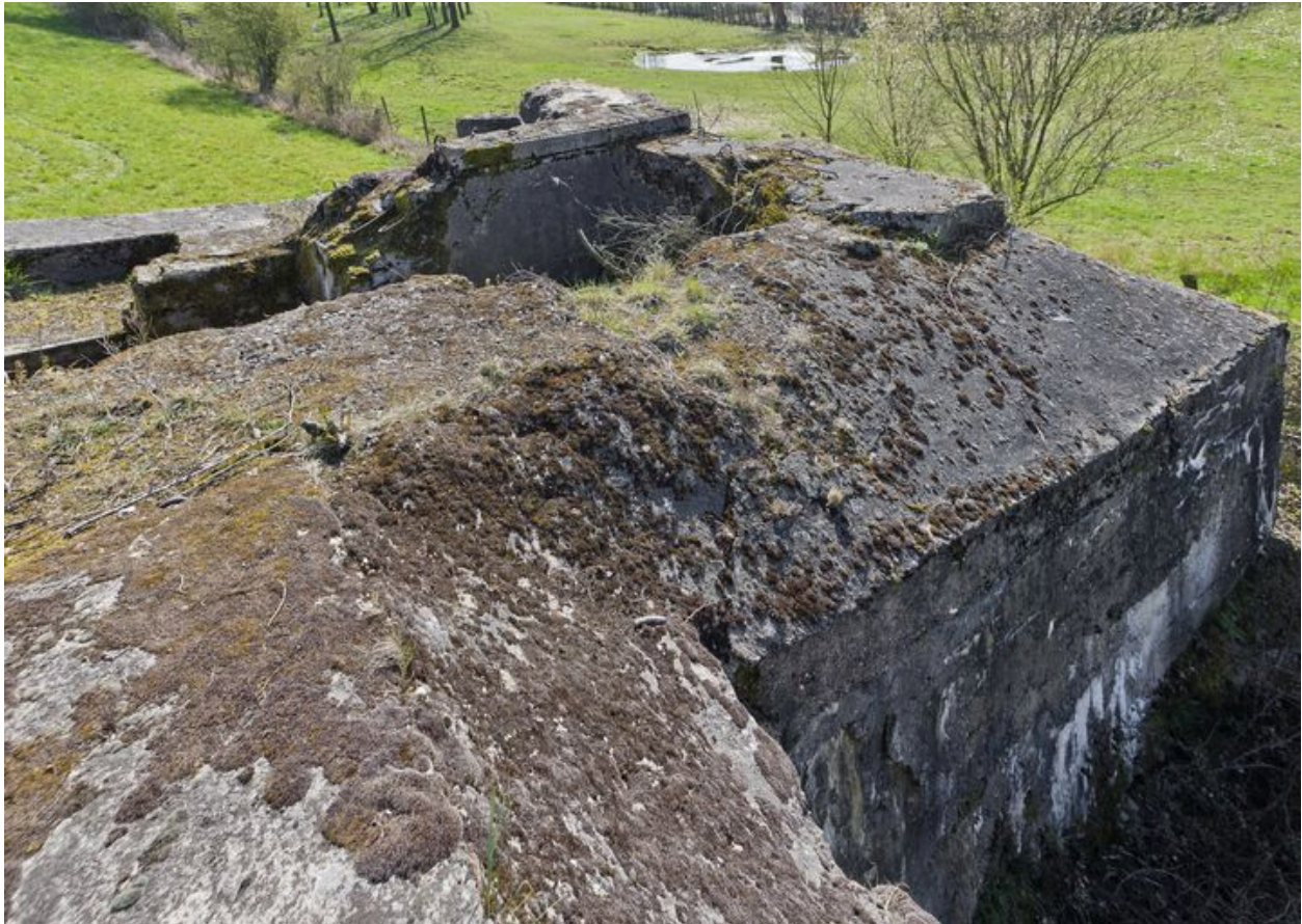
Casemate A. Depuis la position pour mitrailleuse, vers le sud
