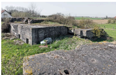
Depuis le toit de la casemate B : La casemate A, vers l'ouest Phot. Jean-Marc Ramette IVR31_20145904212NUCA
