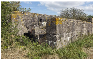
Casemate B: Elévation sud-est. Banquette d'Infanterie et mur pare-souffle Phot. Jean-Marc Ramette IVR31_20145904344NUCA
