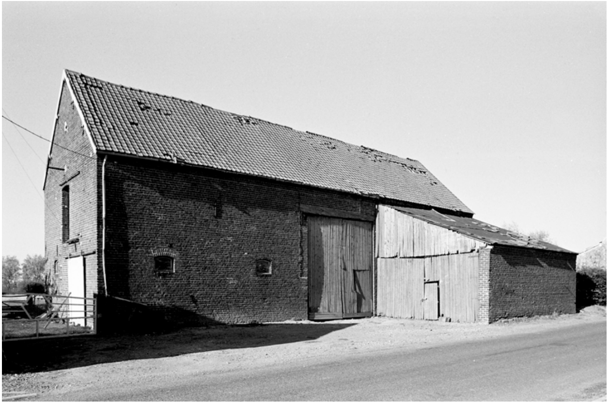
Vue d'ensemble de la grange, depuis le sud.
