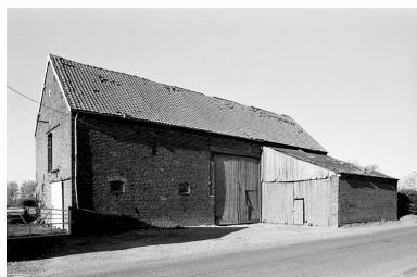
Vue d'ensemble de la grange, depuis le sud. Phot. Christiane Riboulleau IVR22_19900202522Z
