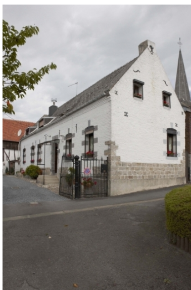
Vue générale d'une ferme située 7 Grand'Place. Phot. Pierre Thibaut IVR31_20095902670NUCA
