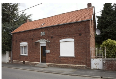
Vue d'une maison datée 1924, située 20 Grand'Rue. Phot. Pierre Thibaut IVR31_20095902683NUCA
