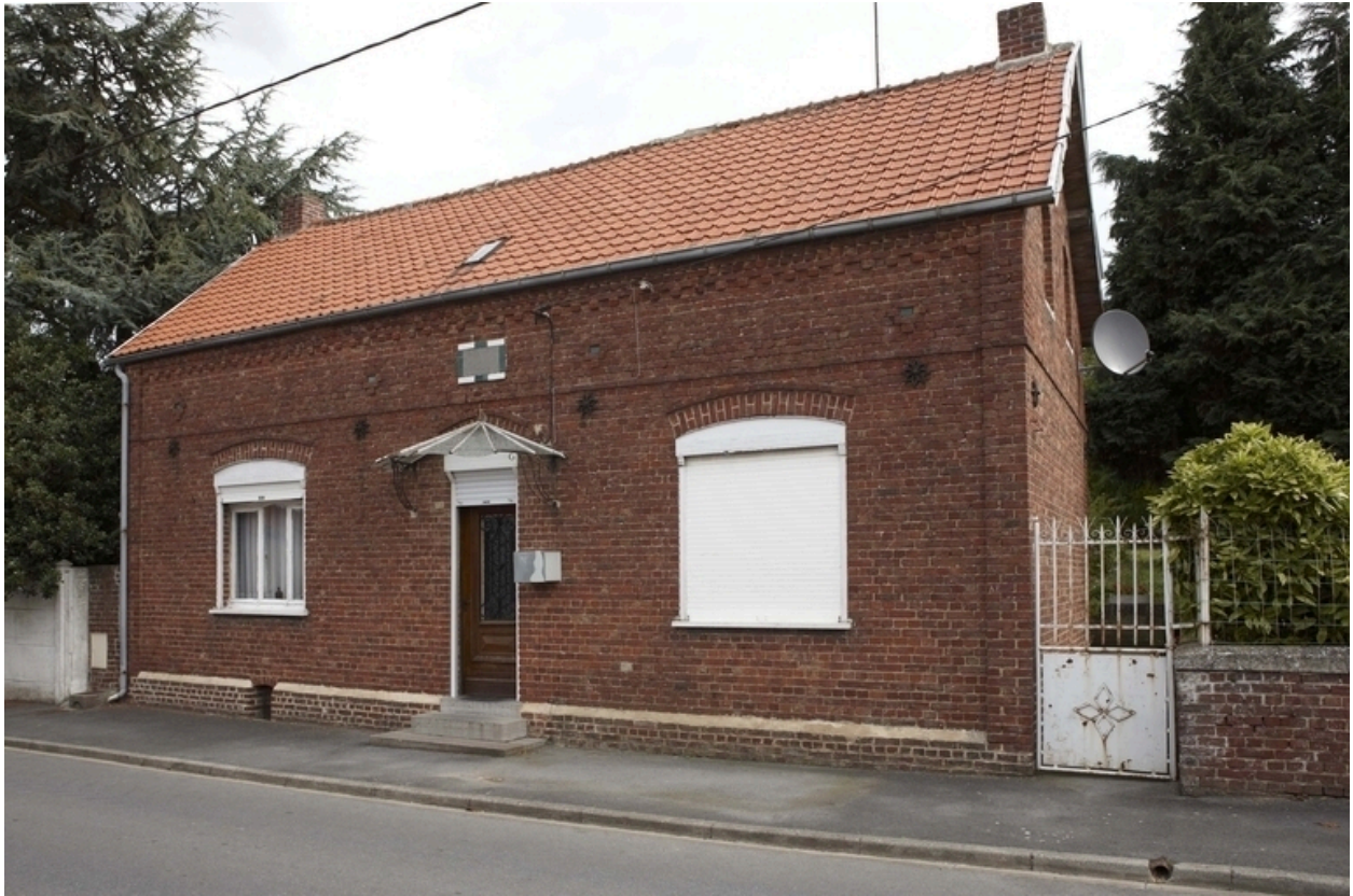
Vue d'une maison datée 1924, située 20 Grand'Rue.
