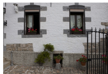
Détail de la blocure murée en façade sur cour du logis d'une ferme située 7 Grand'Place. Phot. Pierre Thibaut IVR31_20095902667NUCA
