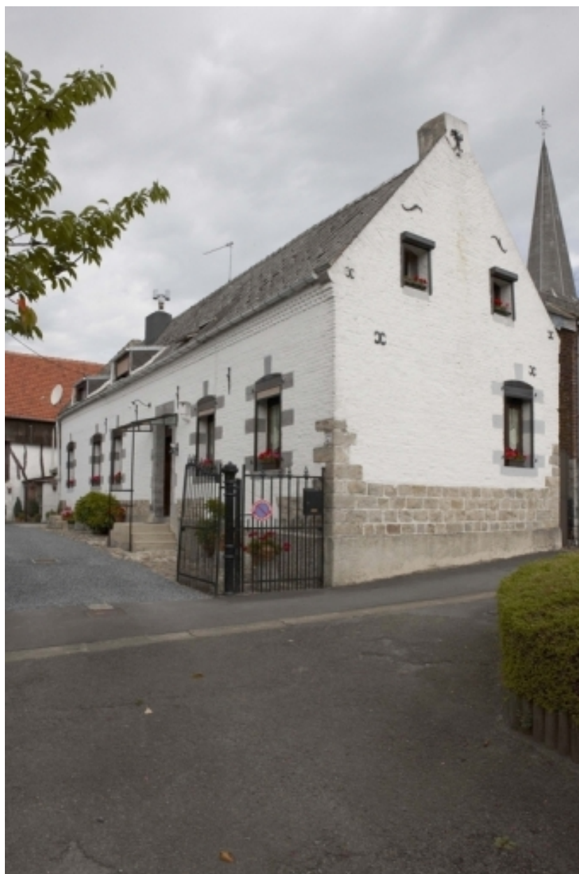
Vue générale d'une ferme située 7 Grand'Place.
