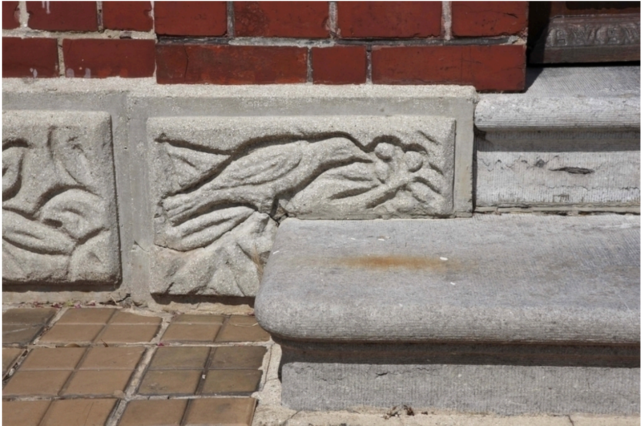
Détail du soubassement d'une maison située 1 rue du Quesnoy.
