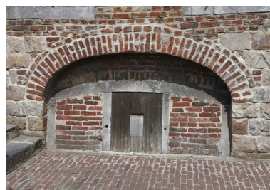
Détail d'une blocure murée (ferme située ruelle du Garde). Phot. Pierre Thibaut IVR31_20095902732NUCA
