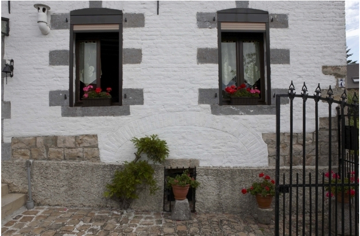
Détail de la blocure murée en façade sur cour du logis d'une ferme située 7 Grand'Place.
