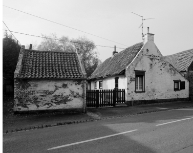
Vue générale. Phot. Philippe Dapvriil IVR31_20045900676X
