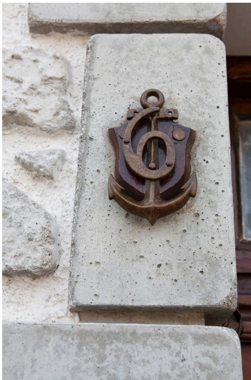
Maconnerie, détail d'un fer d'ancrage.
