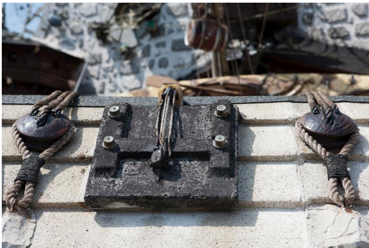
Vue partielle de l'installation.
