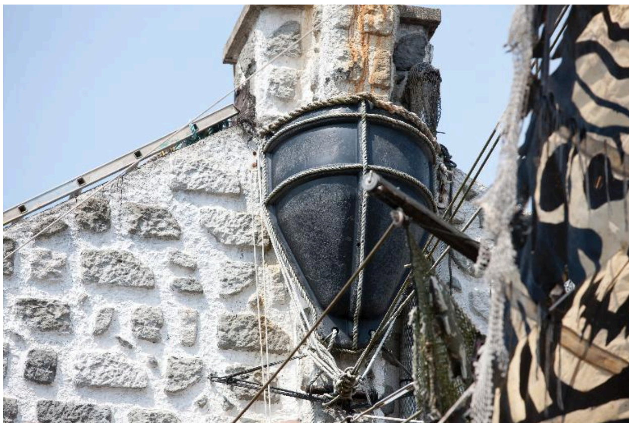
Vue partielle du pignon.
