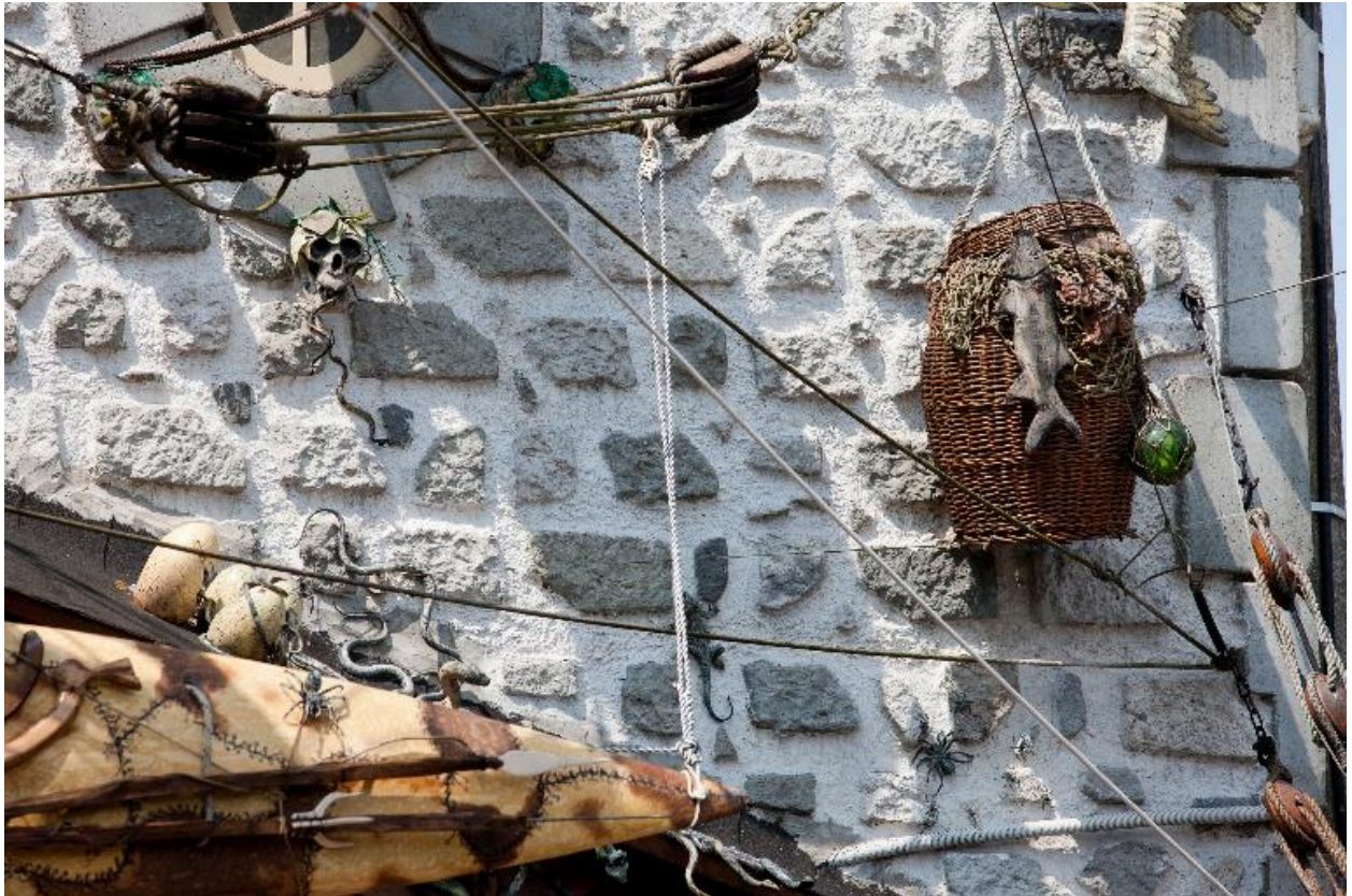
Vue partielle du pignon.
