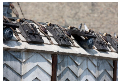
Vue partielle de l'installation. Phot. Hubert Bouvet IVR31_20145902850NUC4A
