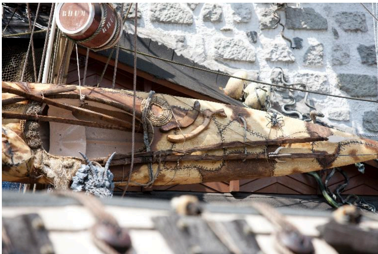
Vue partielle du pignon.
