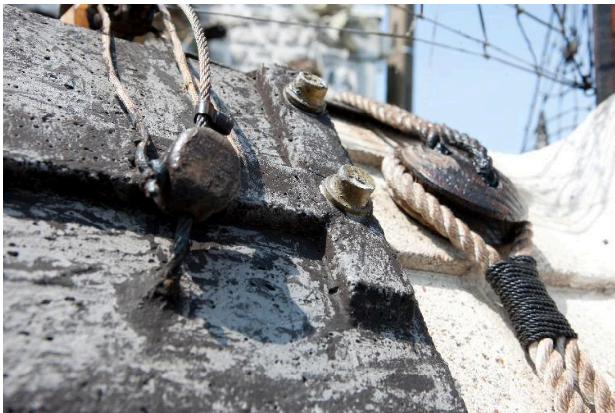
Détail de l'installation.
