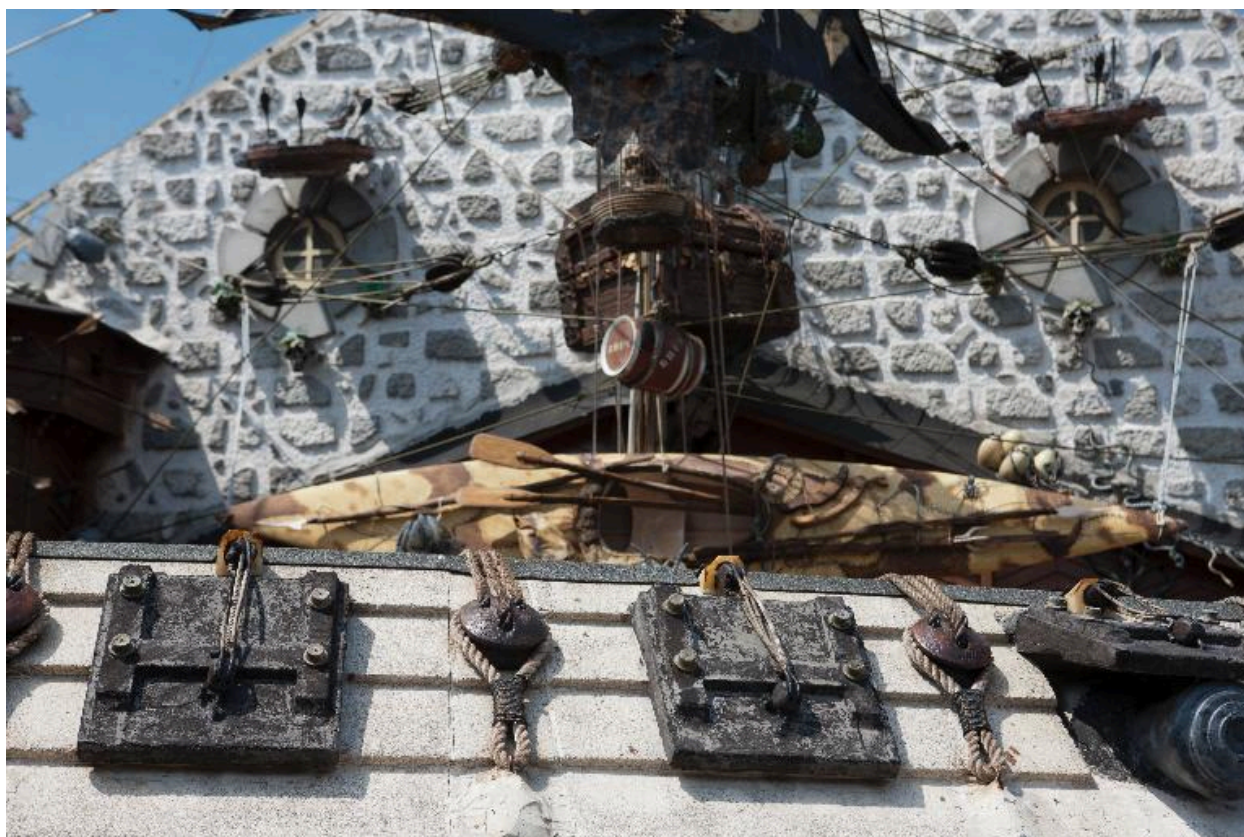
Vue partielle du pignon.
