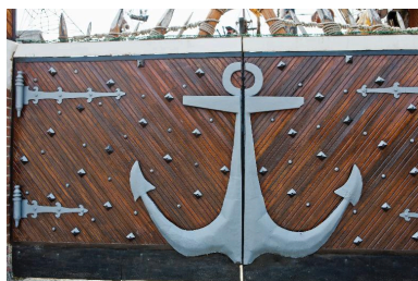
Portail d'entrée sur la cour. Phot. Hubert Bouvet IVR31_20145902835NUC4A
