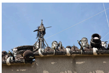
Détail du muret. Phot. Hubert Bouvet IVR31_20145902822NUC4A
