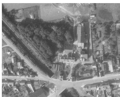
Vue aérienne du site, 1979 (IGN ; C0145-0241_1979_F1-14-12_0122). IVR32_20208005214NUCA
