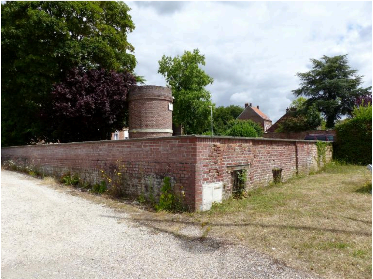
Base de l'ancien pavillon.
