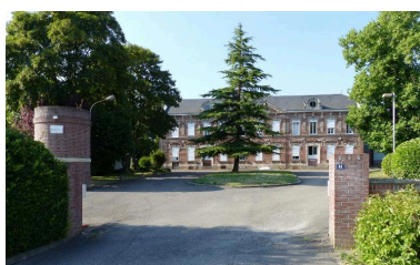
Vue de situation. Phot. Isabelle Barbedor IVR32_20168005761NUCA
