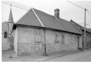
Vue générale depuis la rue. Phot. Jean-Michel Perrin IVR22_19846000967X
