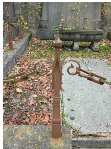
Détail d'un pilier. Phot. Laurent Nicolas IVR22_20048001207NUCA
