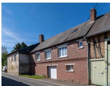
Maison datée de 1955 (date portée sur la façade), n°28 rue des Fresnes, vue depuis l'est. Phot. Marc Kérignard IVR32_20226000453NUCA
