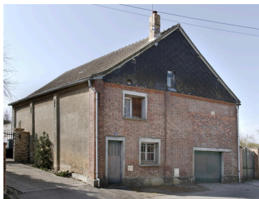
Ancienne grange aménagée en maison, construite en 1869, n°19 rue du Chauffour, vue depuis le sud-est. Phot. Marc Kérignard IVR32_20216000154NUCA
