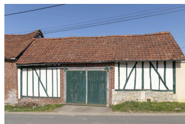
Ancienne grange sur rue remaniée, n°15 rue des Fresnes, vue depuis le sud-ouest. Phot. Marc Kérignard IVR32_20216000141NUCA
