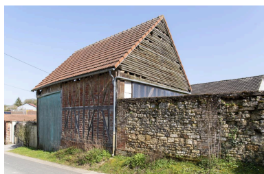
Ancienne grange alignée sur la rue, n°7 rue des Fresnes, vue depuis le nord-ouest. Phot. Marc Kérignard IVR32_20216000138NUCA
