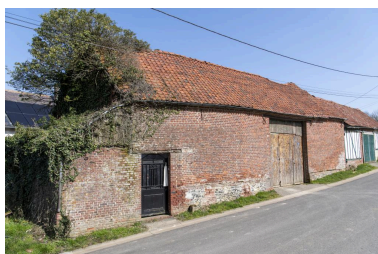
Ancienne grange sur rue reconstruite en 1868, n°13 rue des Fresnes, vue depuis le nord-ouest. Phot. Marc Kérignard IVR32_20216000140NUCA
