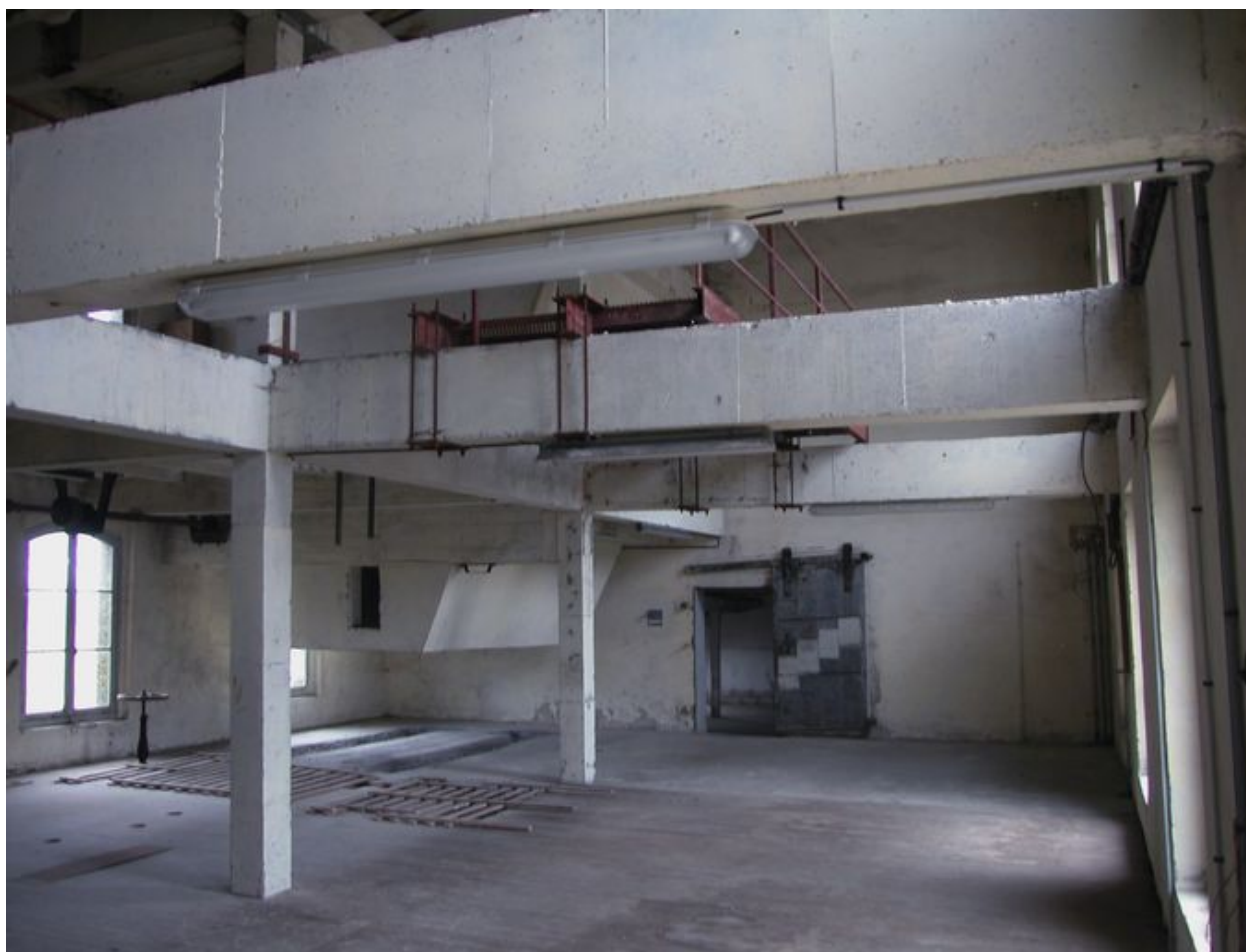
Intérieur du premier étage de la minoterie.
