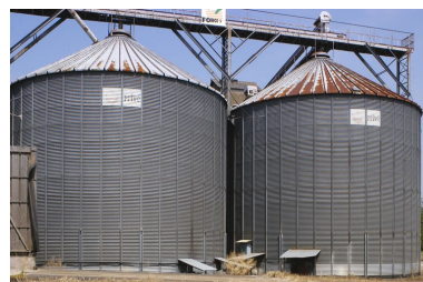
Les silos modernes, vue d'ensemble. Phot. Thierry Lefébure IVR22_20046000166NUCA
