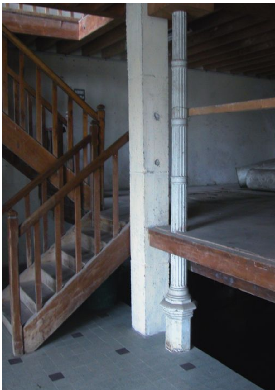
Détail d'une colonne cannelée en fonte, rez-de-chaussée.
