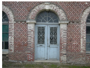
Détail de la porte d'entrée. Phot. Bertrand Fournier IVR22_20046002784NUCA
