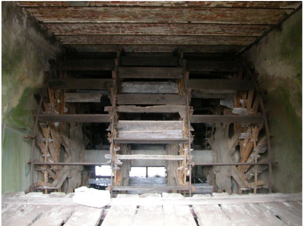
La roue hydraulique, vue de face.
