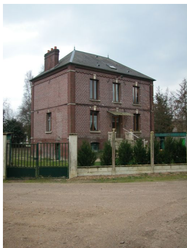
Logement patronal, ensemble postérieur. Phot. Bertrand Fournier IVR22_20046002781NUCA
