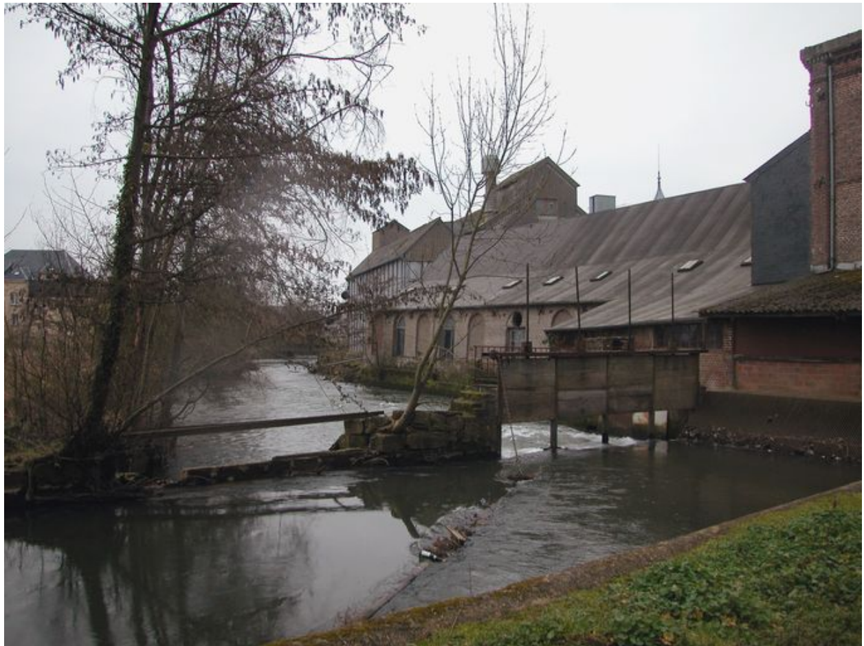
Le vannage de décharge et le déversoir.
