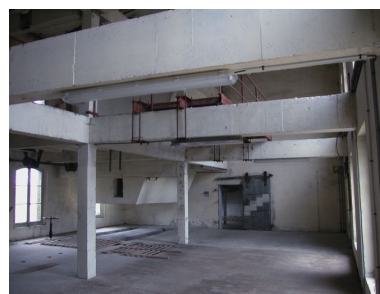
Intérieur du premier étage de la minoterie. Phot. Bertrand Fournier IVR22_20046002792NUCA
