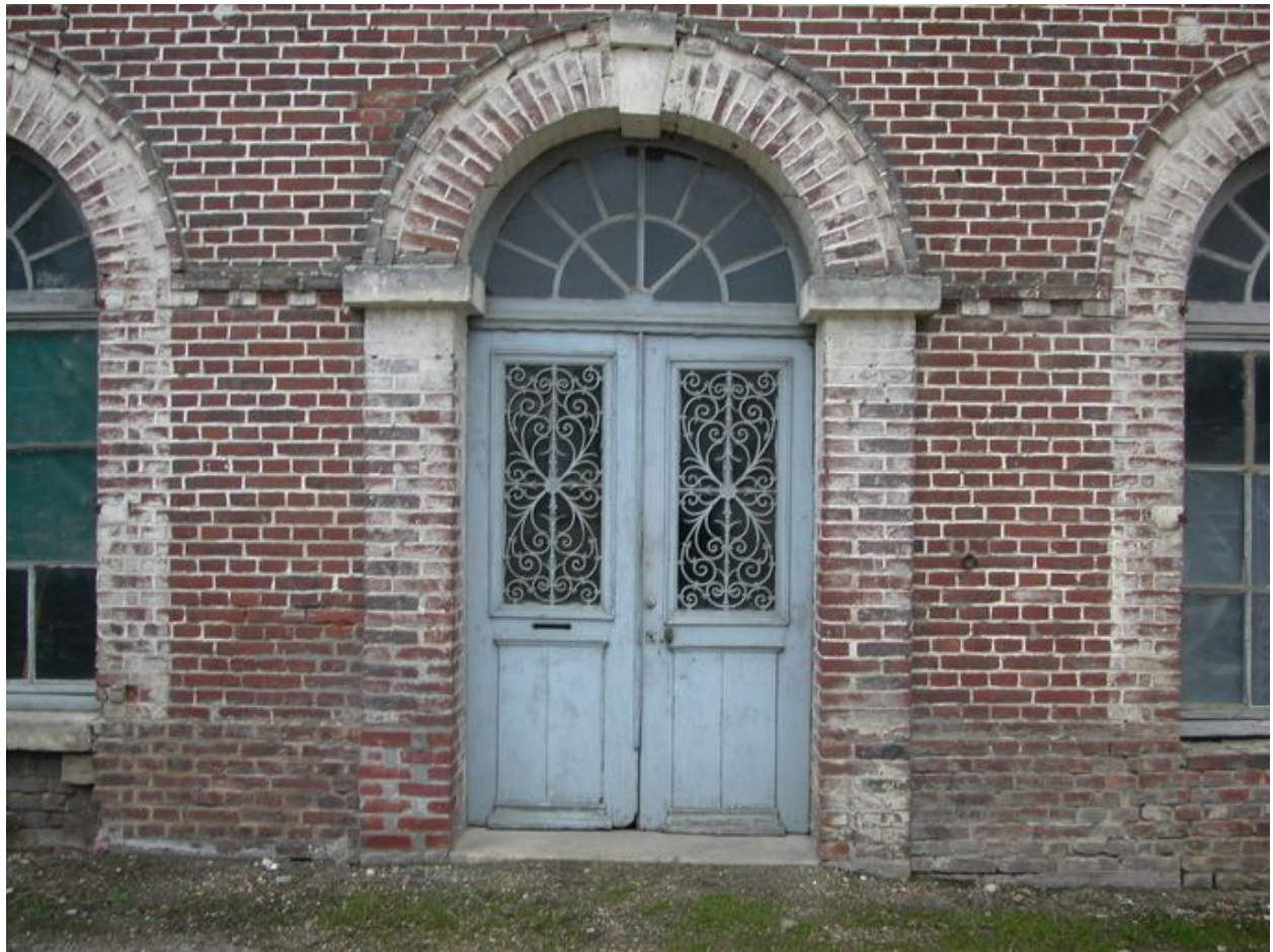
Détail de la porte d'entrée.
