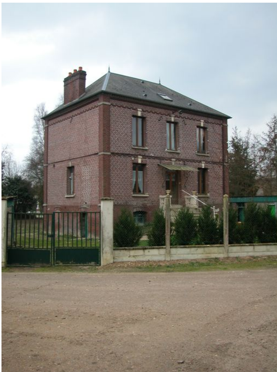
Logement patronal, ensemble postérieur.
