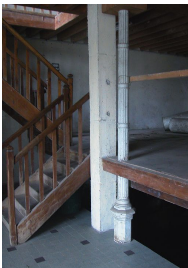
Détail d'une colonne cannelée en fonte, rez-de-chaussée.
