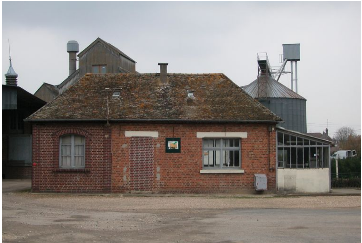
Le bureau, façade sur cour.
