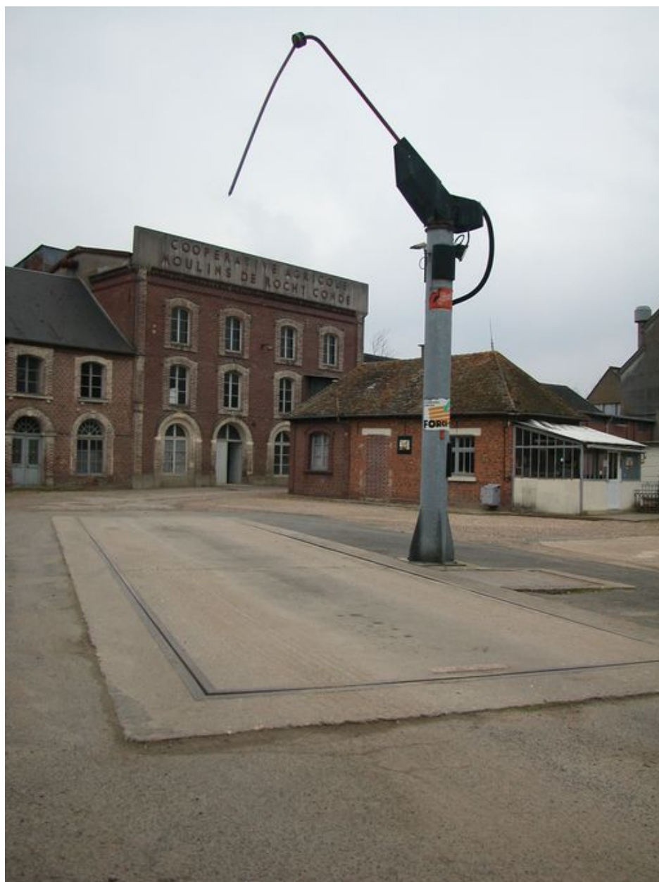
Vue d'ensemble de la minoterie sur cour.
