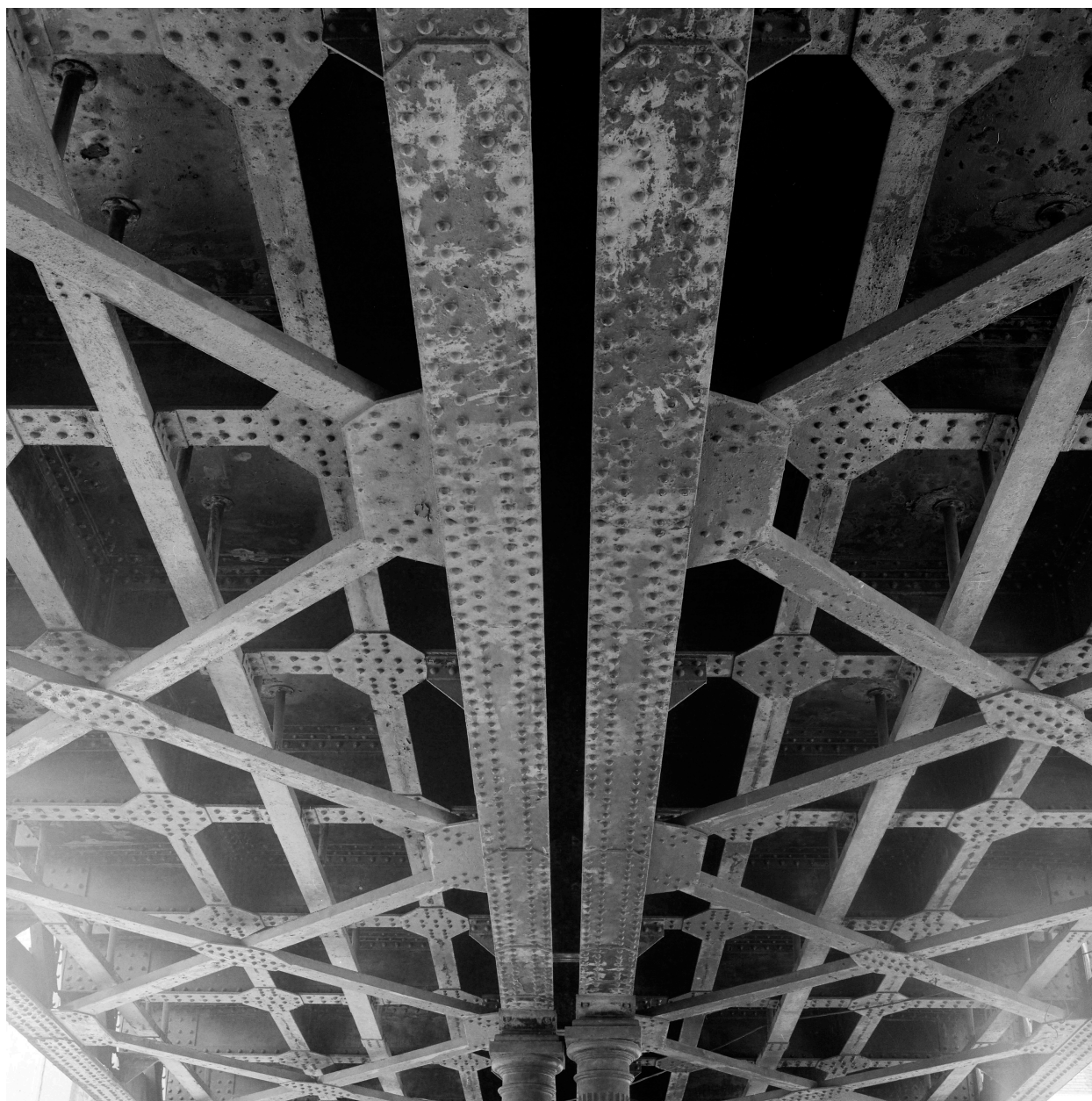
Ossature métallique, détail.
