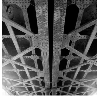
Ossature métallique, détail. Phot. Philippe Dapvril IVR31_19896200720X
