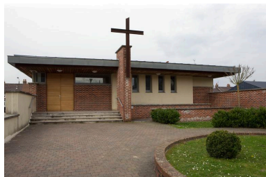
Vue générale. Phot. Pierre Thibaut IVR31_20145903142NUCA
