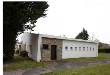
Vue du revers. Phot. Hubert Bouvet IVR31_20106200742NUCA
