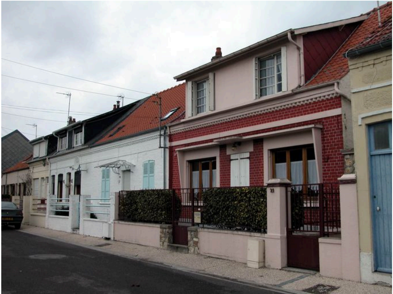
Maisons, 15 à 21 rue du 11 Novembre.
