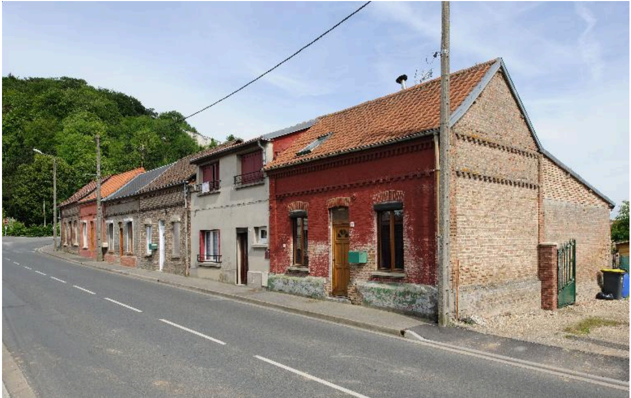
Vue d'ensemble sur rue.
