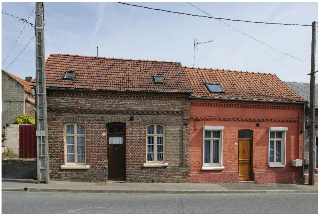
Façade sur rue de deux logements de la cité Calmont.
