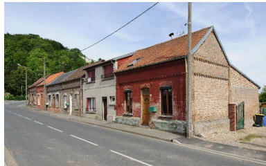
Vue d'ensemble sur rue. Phot. Thierry Lefébure IVR22_20128000310NUC2A
