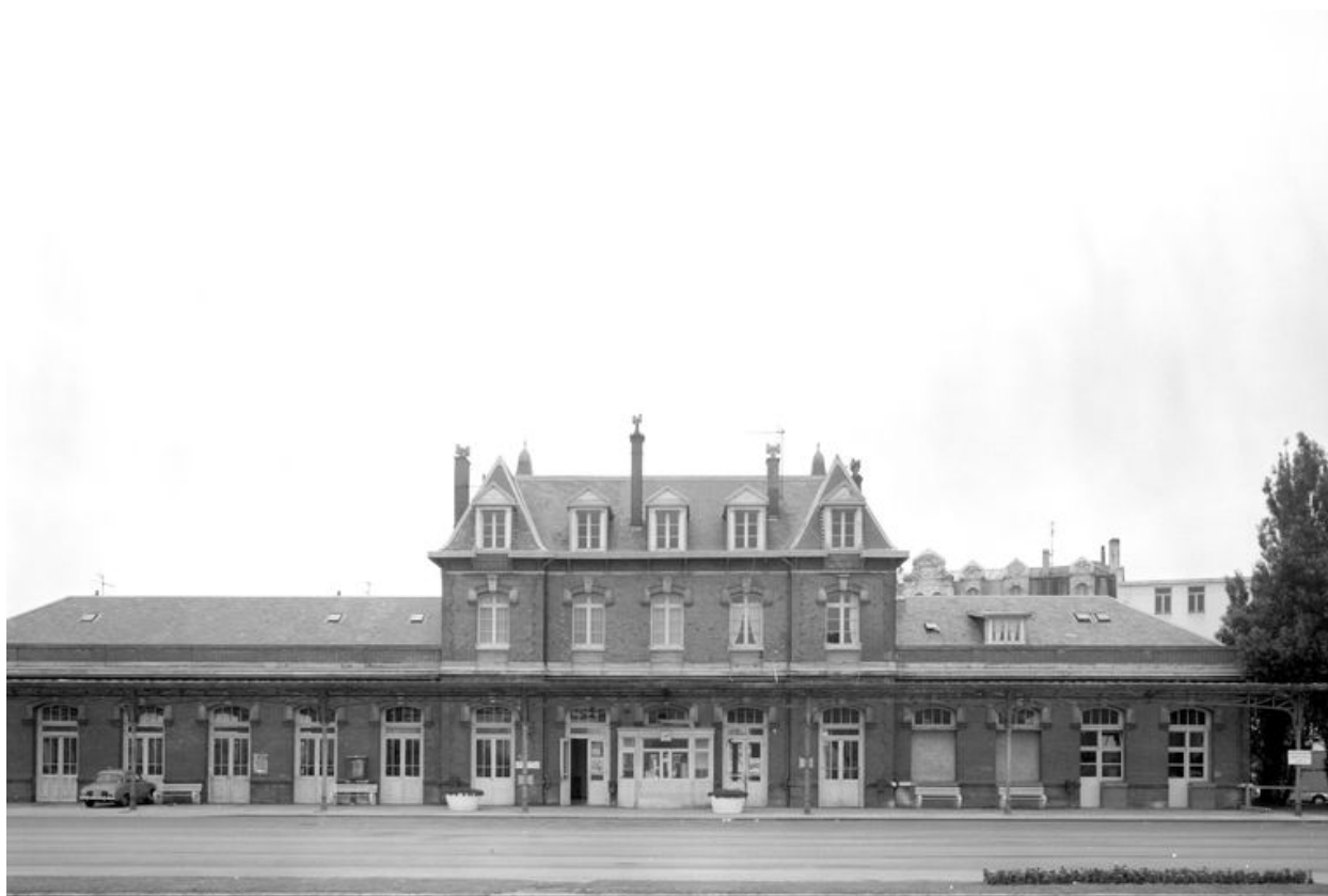
Elévation postérieure de la gare de Berck-plage en 1981.
