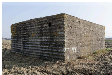
Vue de trois-quarts vers le sud-est Phot. Pierre Thibaut IVR31_20145905324NUCA
