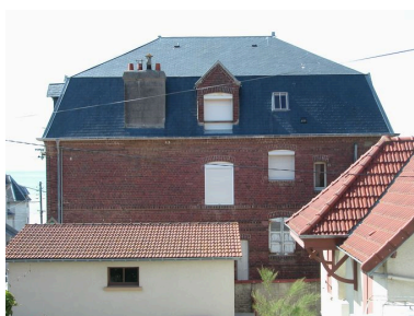
Élévation latérale droite, vue depuis la rue de Saint-Valery. Phot. Elisabeth Justome IVR22_20048001537NUCA
