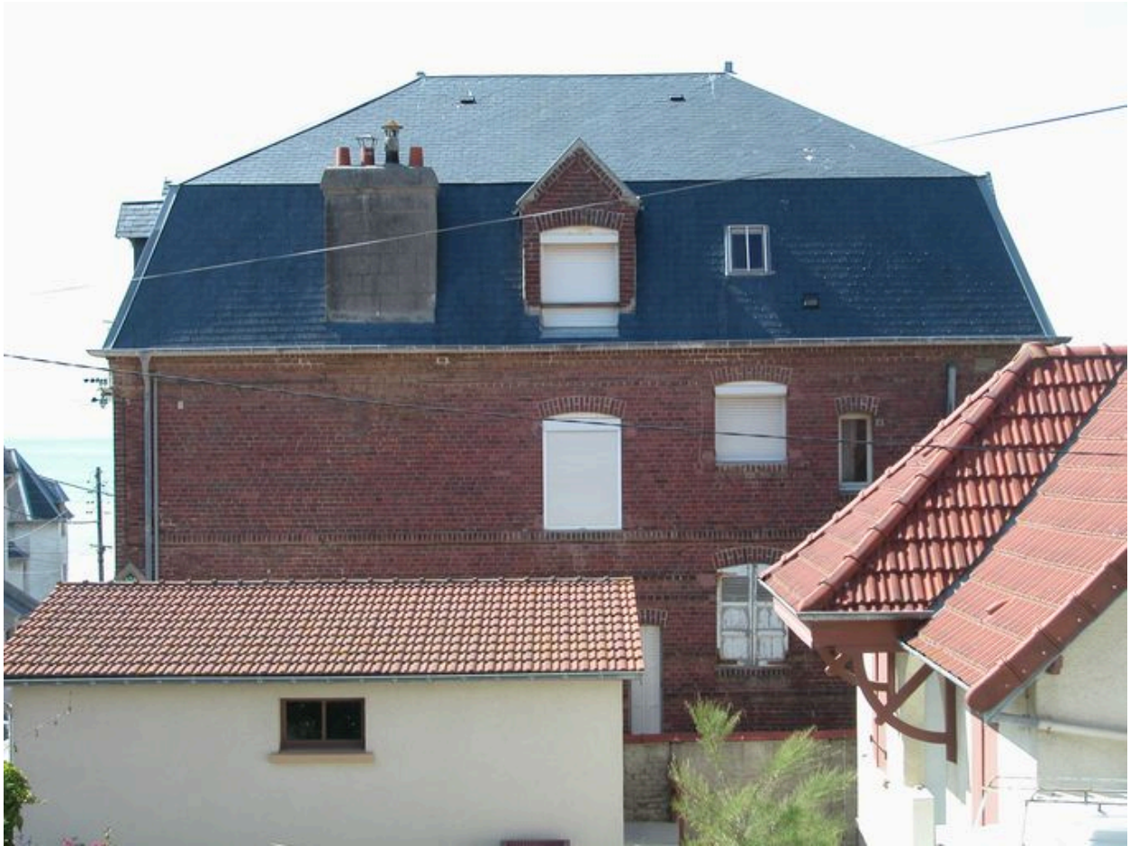
Elévation latérale droite, vue depuis la rue de Saint-Valery.
