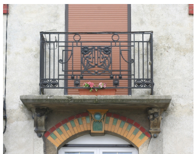
Vue de détail sur un balcon en ferronnerie. Phot. Frédéric Pillet IVR22_20060205022NUCA
