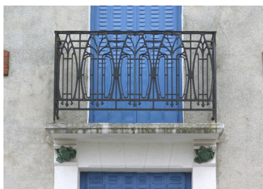
Vue de détail sur un balcon en ferronnerie. Phot. Frédéric Pillet IVR22_20060205023NUCA
