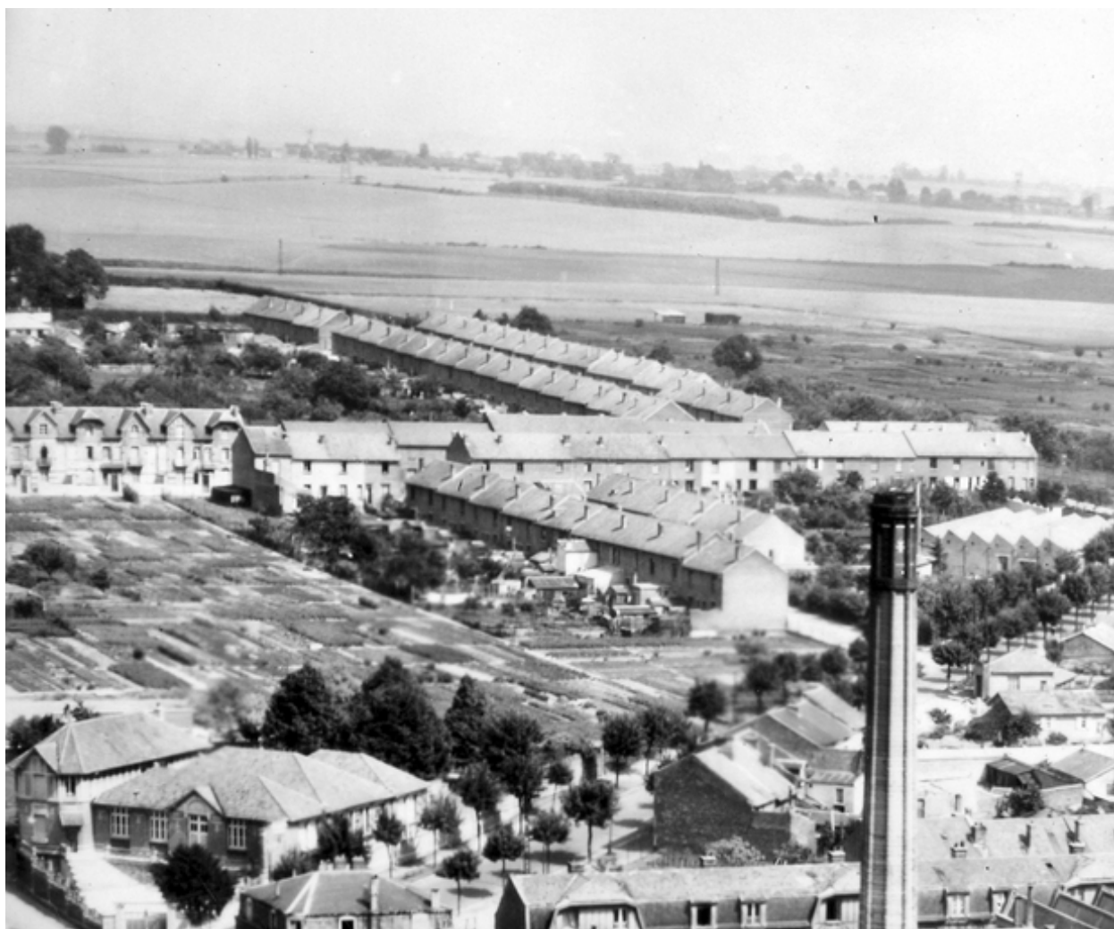
Vue aérienne, vers 1960 (AD Aisne).
