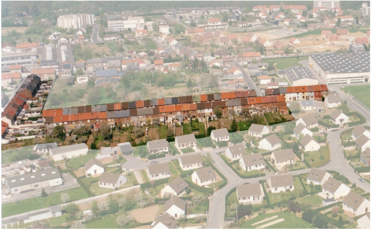
Vue aérienne vers 1989 (BM Saint-Quentin).
