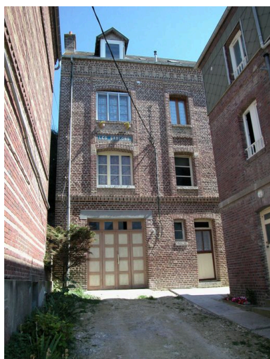
Maison dite Les Sablons, vue d'ensemble. Phot. Elisabeth Justome IVR22_20058002985NUCA
