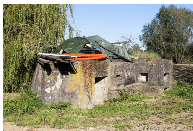
Vue de trois-quarts vers l'est. Phot. Pierre Thibaut IVR31_20155901684NUCA
