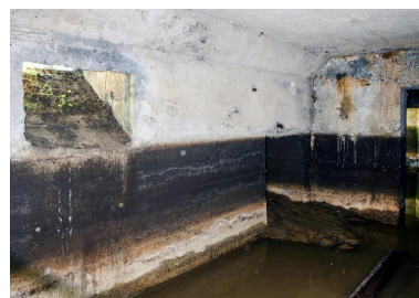
Salle est. De gauche à droite : aération, remise à mitrailleuse et passage vers la salle ouest Phot. Pierre Thibaut IVR31_20155901682NUCA
