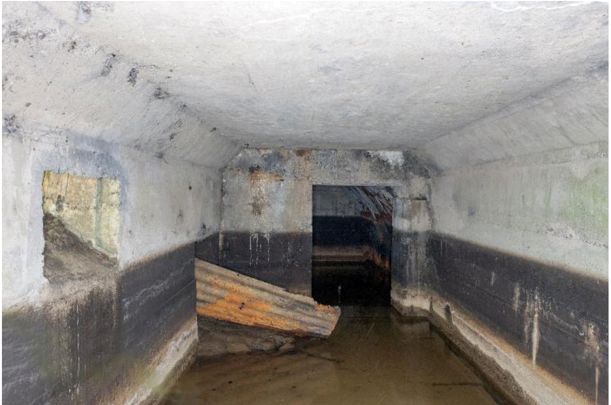
Vue interieure, vers l'ouest
