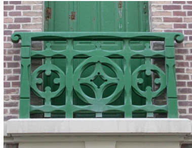
Détail du balcon en menuiserie. Phot. Elisabeth Justome IVR22_20048001395NUCA
