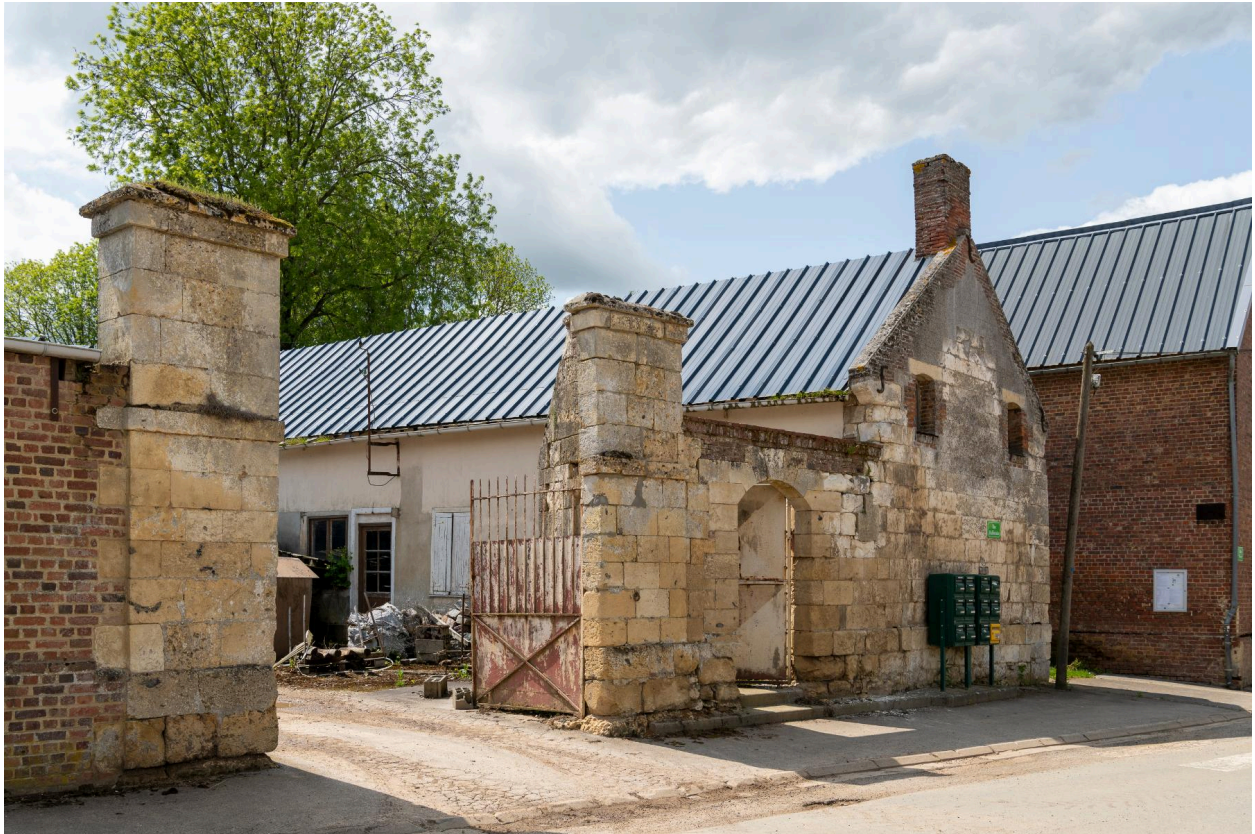
Ancienne ferme de l'abbaye de Breteuil (?), n°8 de la rue Malfontaine, vue depuis le nord.
