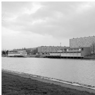
Vue d'ensemble sur le fleuve de la Liane. Phot. Philippe Dapvril IVR31_19946200767X
