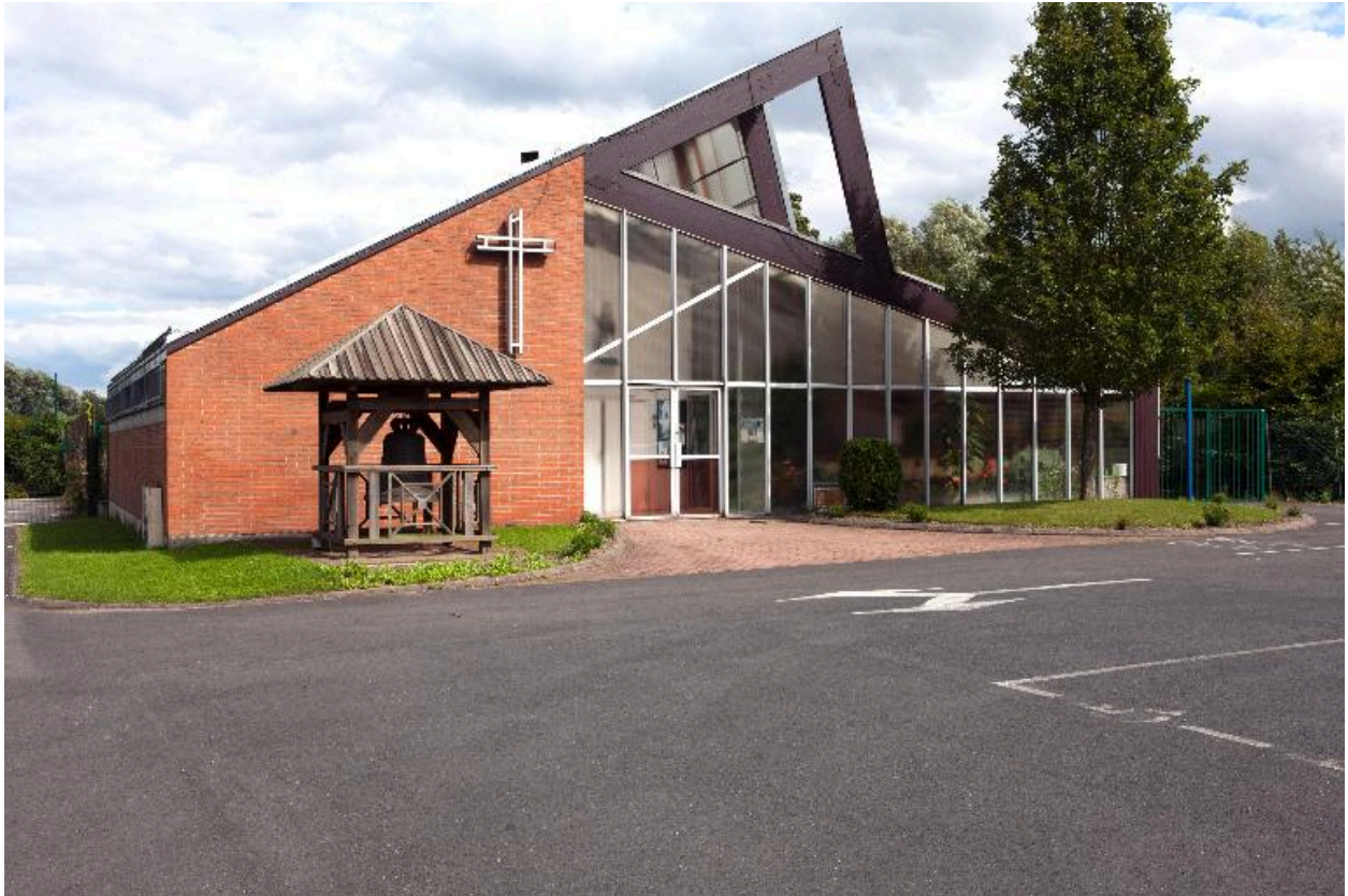
Vue de la façade occidentale.
