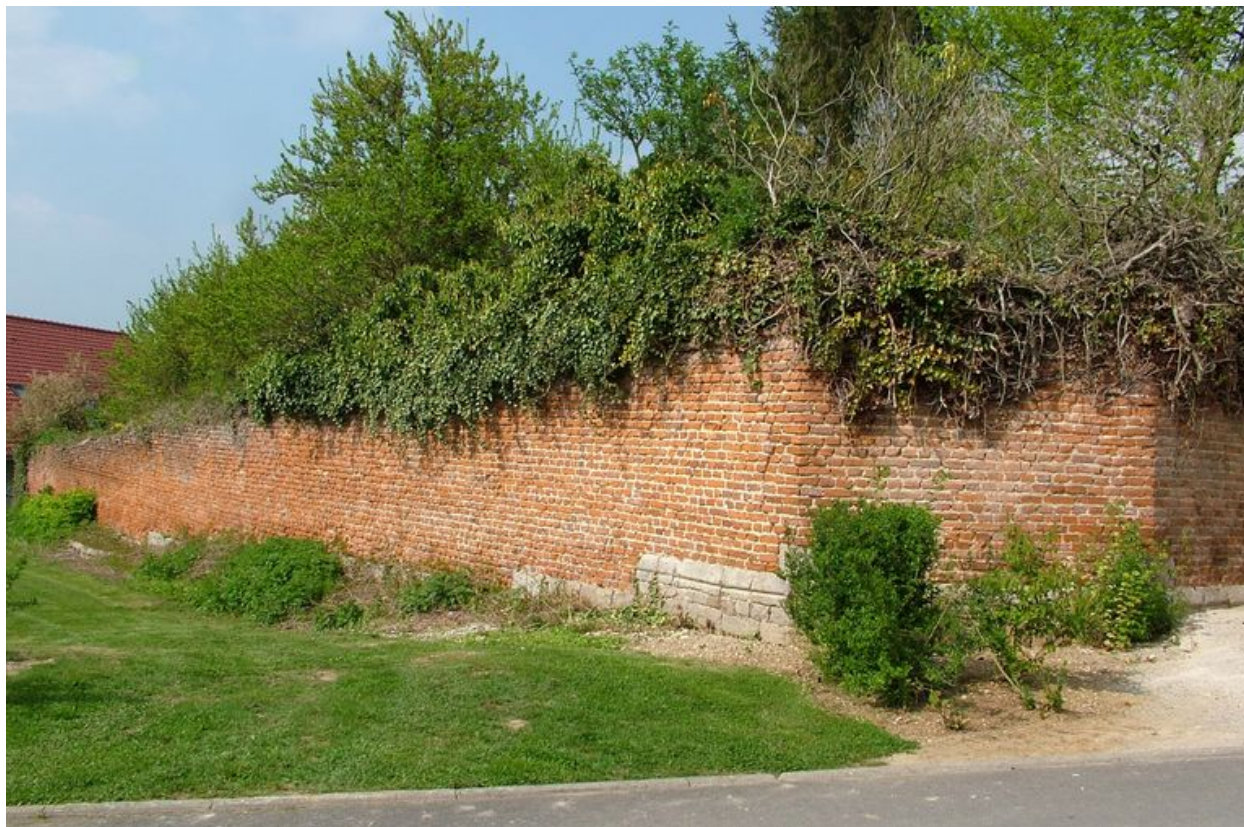
Mur de clôture.
