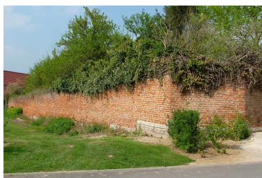
Mur de clôture. Phot. Frédéric Fournis IVR22_20098005202NUCA
