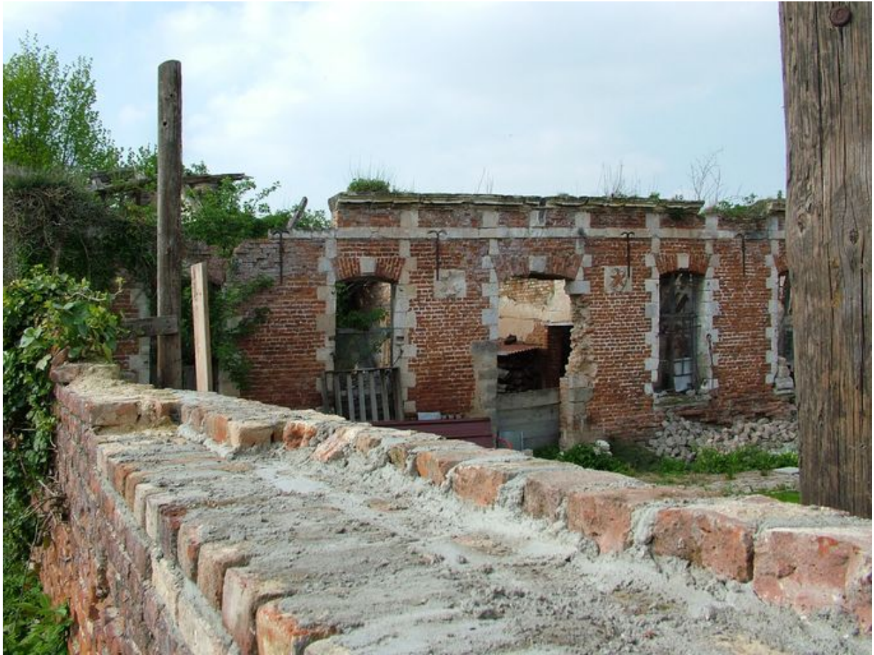
Vestiges du corps de logis depuis le mur de clôture.
