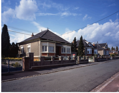
Vue générale de l'alignement des maisons. Phot. Pierre Thibaut IVR31_20085900861VA
