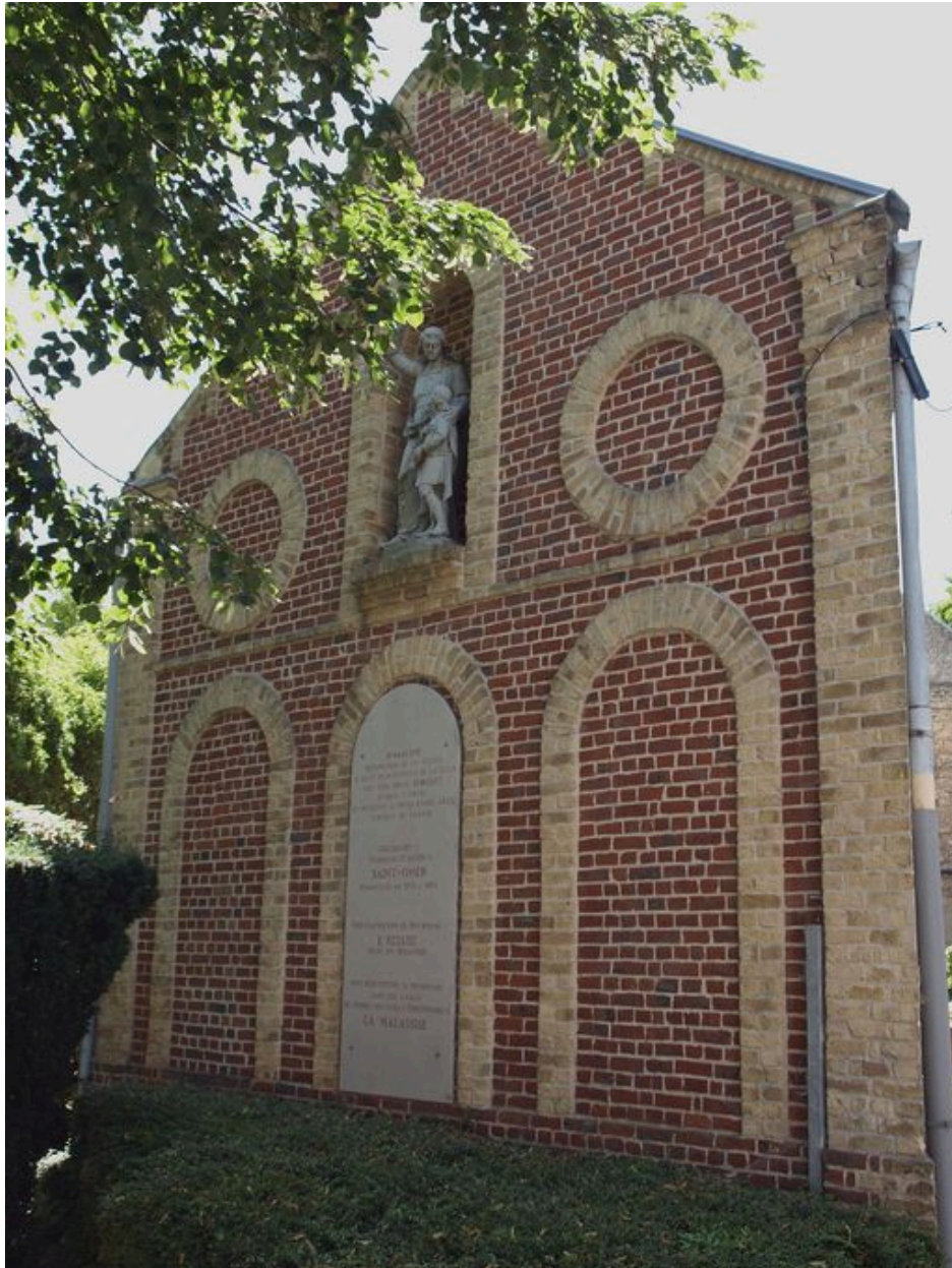
Vue générale de situation
