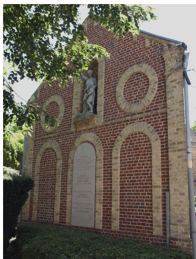
Vue générale de situation Phot. Bruno Decrock IVR31_20106204054NUCA
