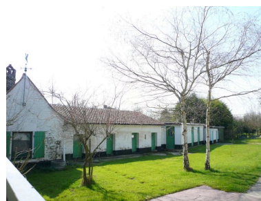
Vue des dépendances. Phot. Inès Guérin IVR22_20078005916NUCA
