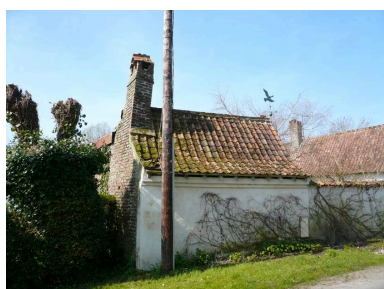
Vue postérieure du fournil. Phot. Inès Guérin IVR22_20078005917NUCA
