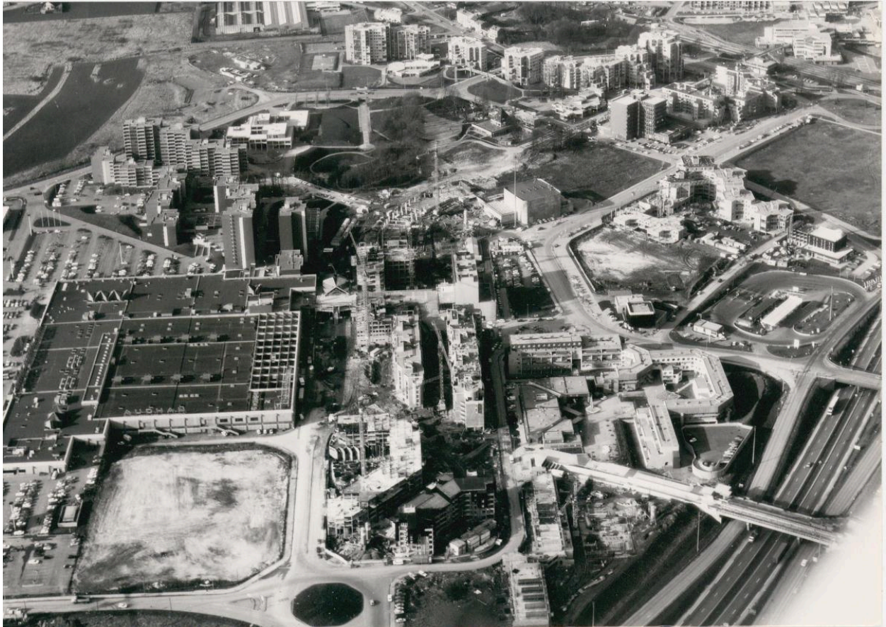
Vue aérienne de la construction de la Chaussée-Haute, quartier Hôtel-de-Ville, en février 1981 (AC Villeneuve-d'Ascq, Phot'R ; 9Fi2154).
