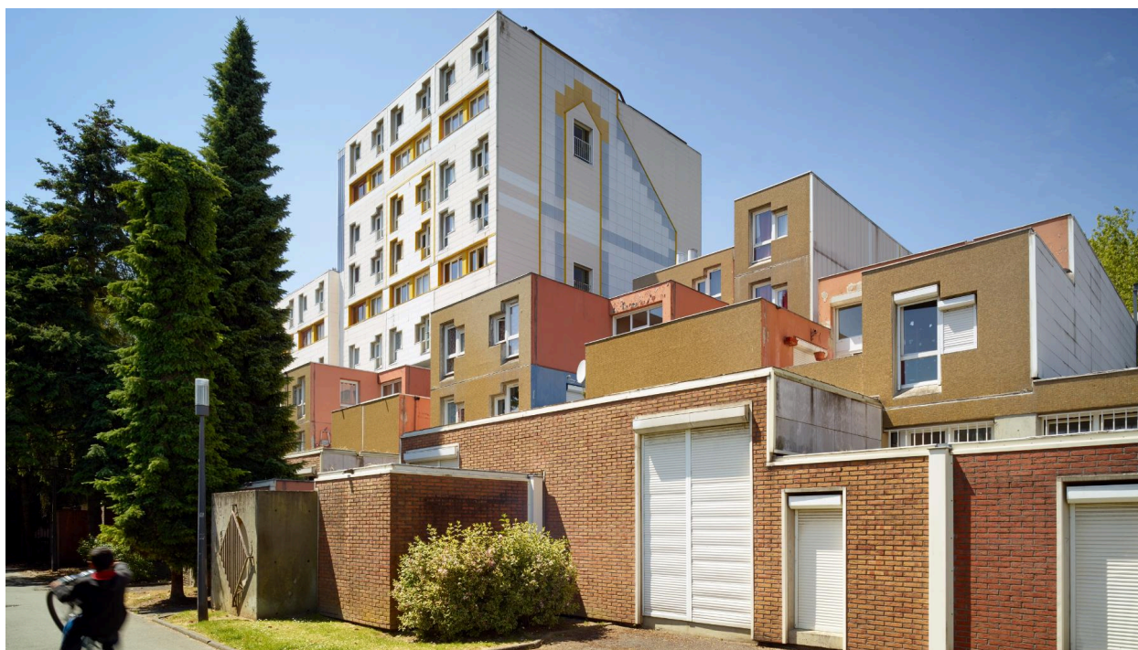
L'îlot 6 au Pont-de-Bois.
