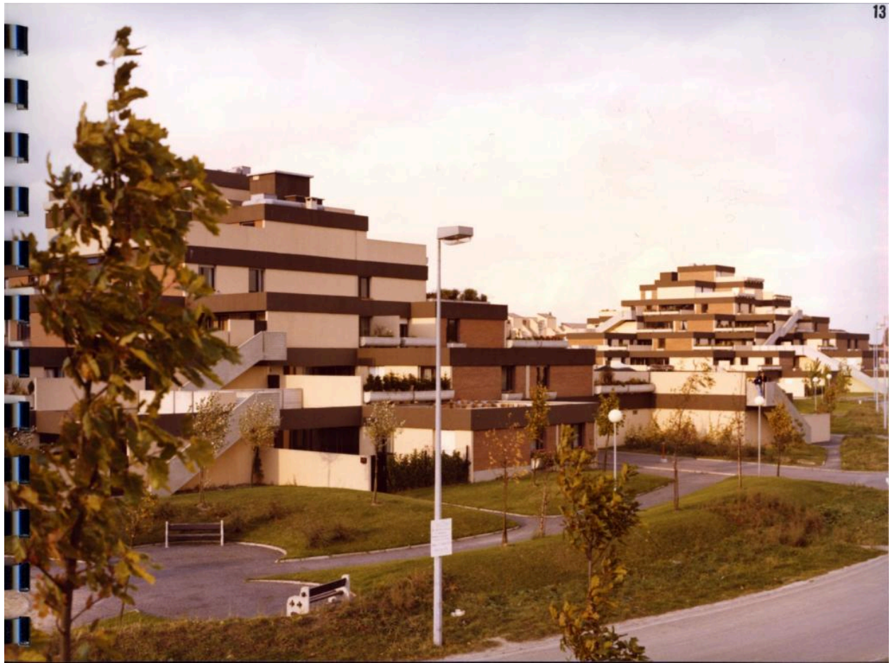
En 1978 : Les Pyramides, quartier Le Château (Michel Andrault et Pierre Parat, 1976) (AC Villeneuve-d'Ascq ; 16W3).
