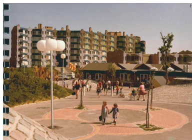
En 1978 : l'espace public central du Triolo ouest en 1979. Au fond, l'îlot 7 et le groupe scolaire Hippolyte-Taine (AC Villeneuve-d'Ascq ; 16W3). Repro. Pierre Thibaut, Phot. auteur inconnu IVR32_20215900432NUCA
