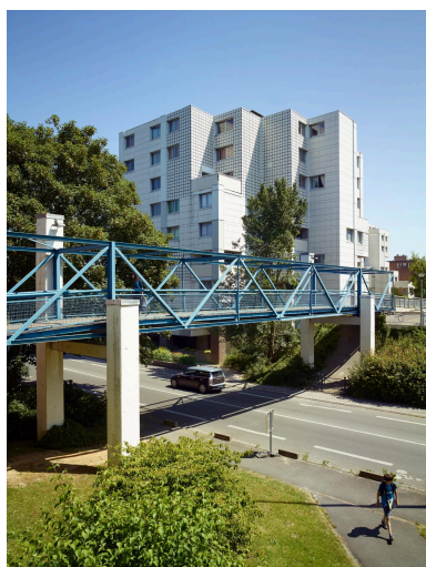
Passerelle piétonne sur le boulevard Van-Gogh (quartier de l'Hôtel-de-Ville). Phot. Pierre Thibaut IVR32_20195900939NUCA
