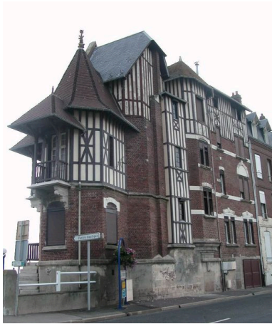
Vue de trois-quarts et élévation postérieure. Phot. Elisabeth Justome IVR22_20058003142NUCA
