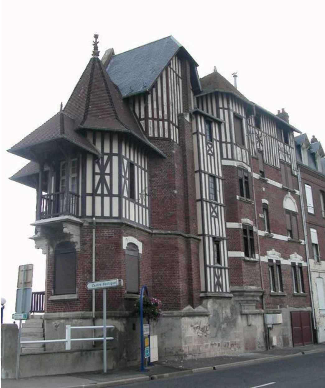
Vue de trois-quarts et élévation postérieure.
