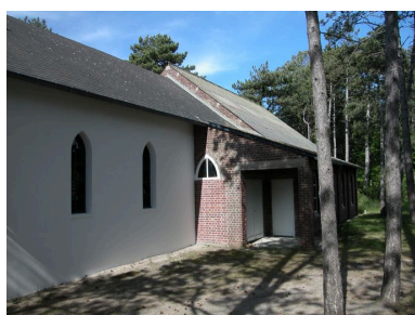
Détail de l'élévation sud.
