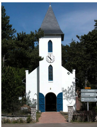
Vue d'ensemble de la façade repeinte.
