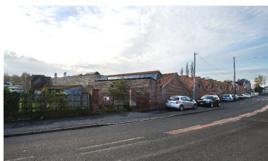
Façade sur rue de l'ancienne filature. Phot. Thierry Lefébure
