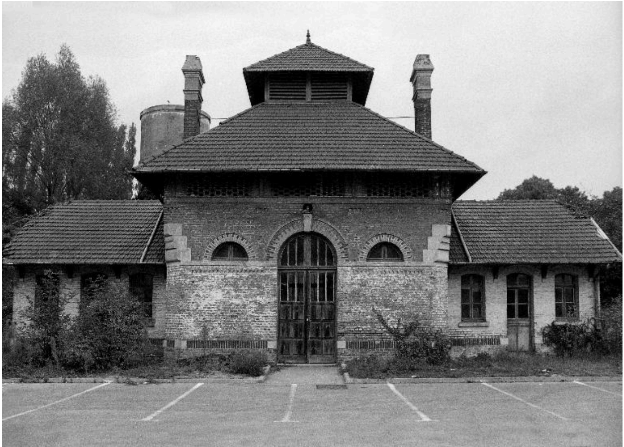
Magasin de commerce, dépendance (blanchisserie), élévation antérieure.
