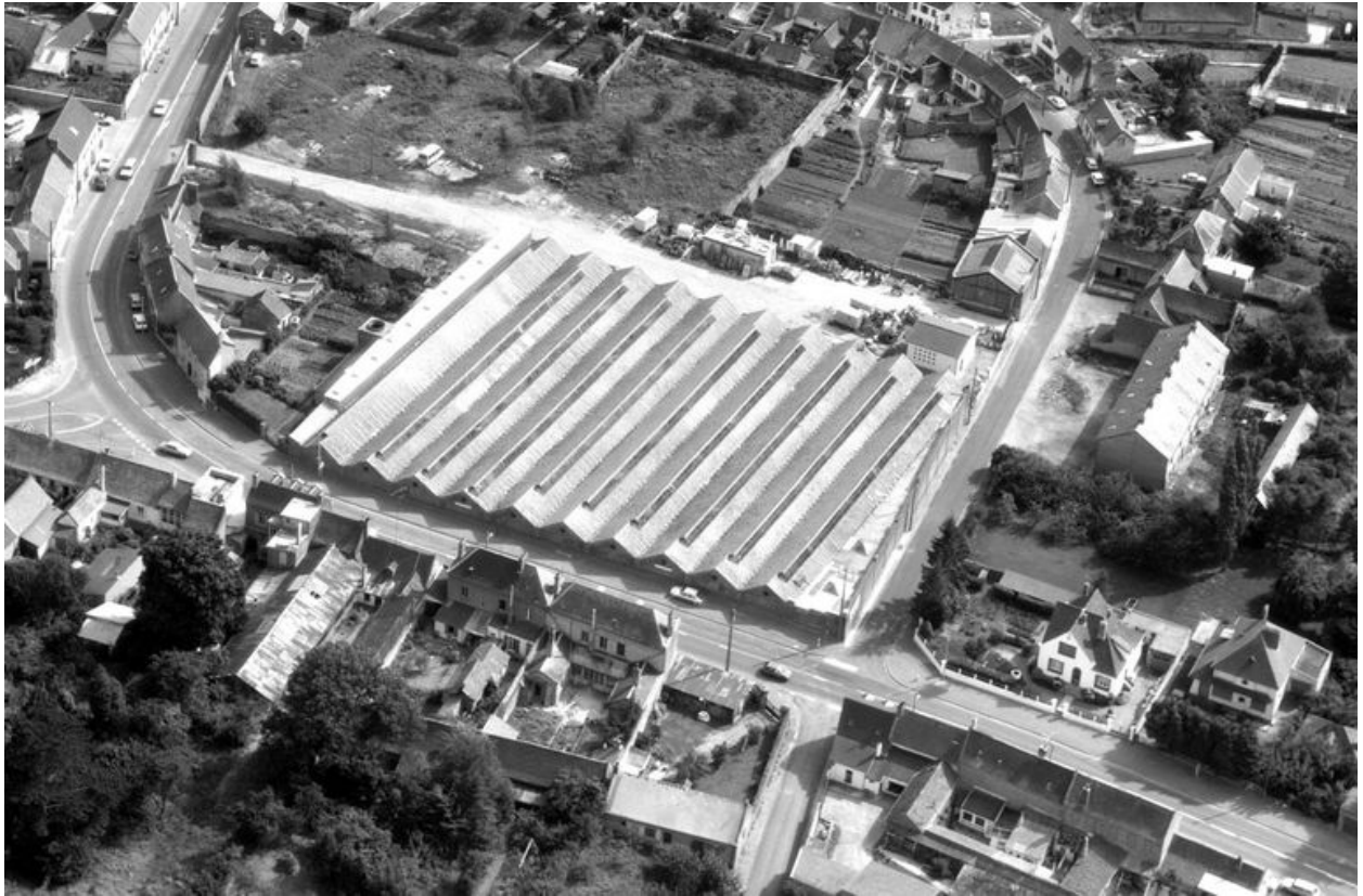
Vue aérienne, flanc est.
