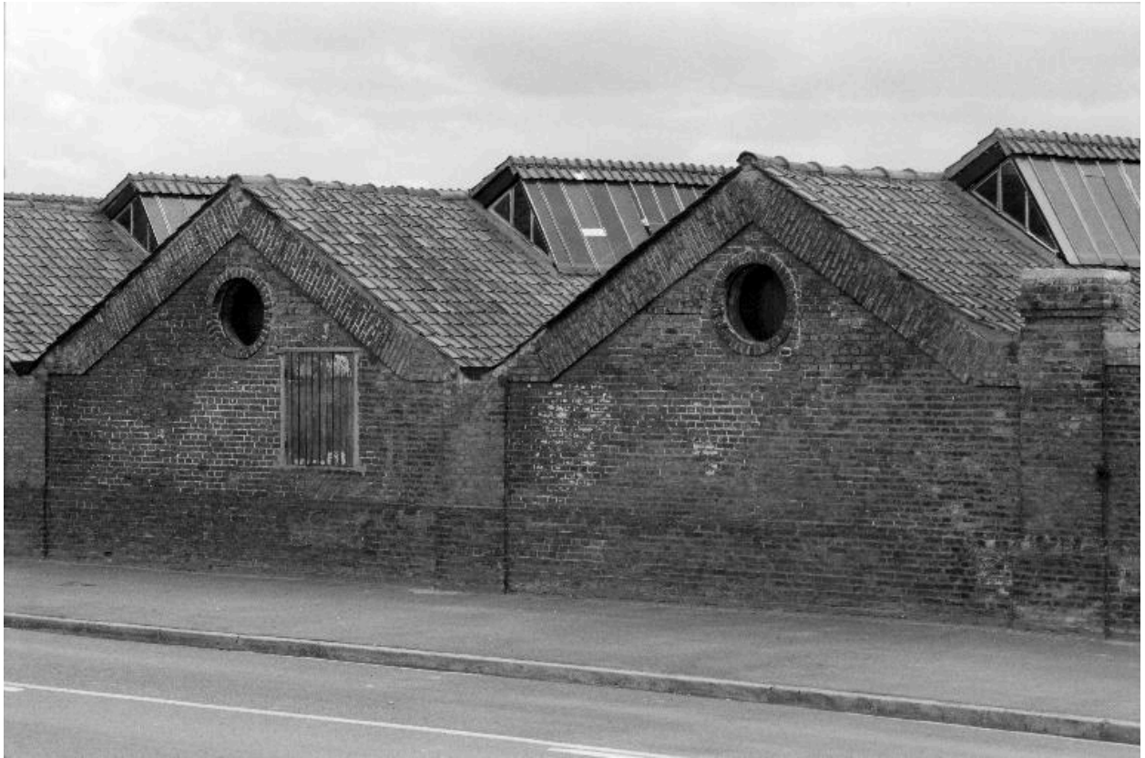
Atelier de fabrication, vue partielle, flanc nord-est.
