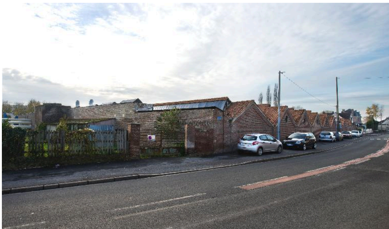
Façade sur rue de l'ancienne filature.
