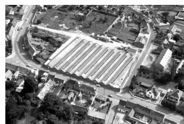
Vue aérienne, flanc est.
