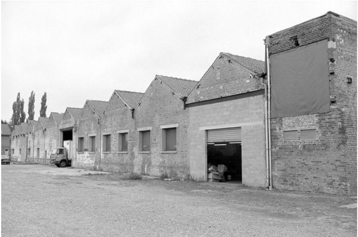
Façade sur cour des ateliers de l'ancienne filature en 1990.
