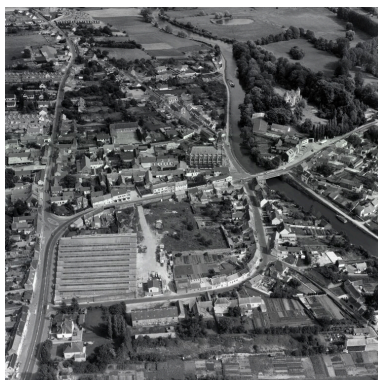
Vue aérienne, flanc ouest.
