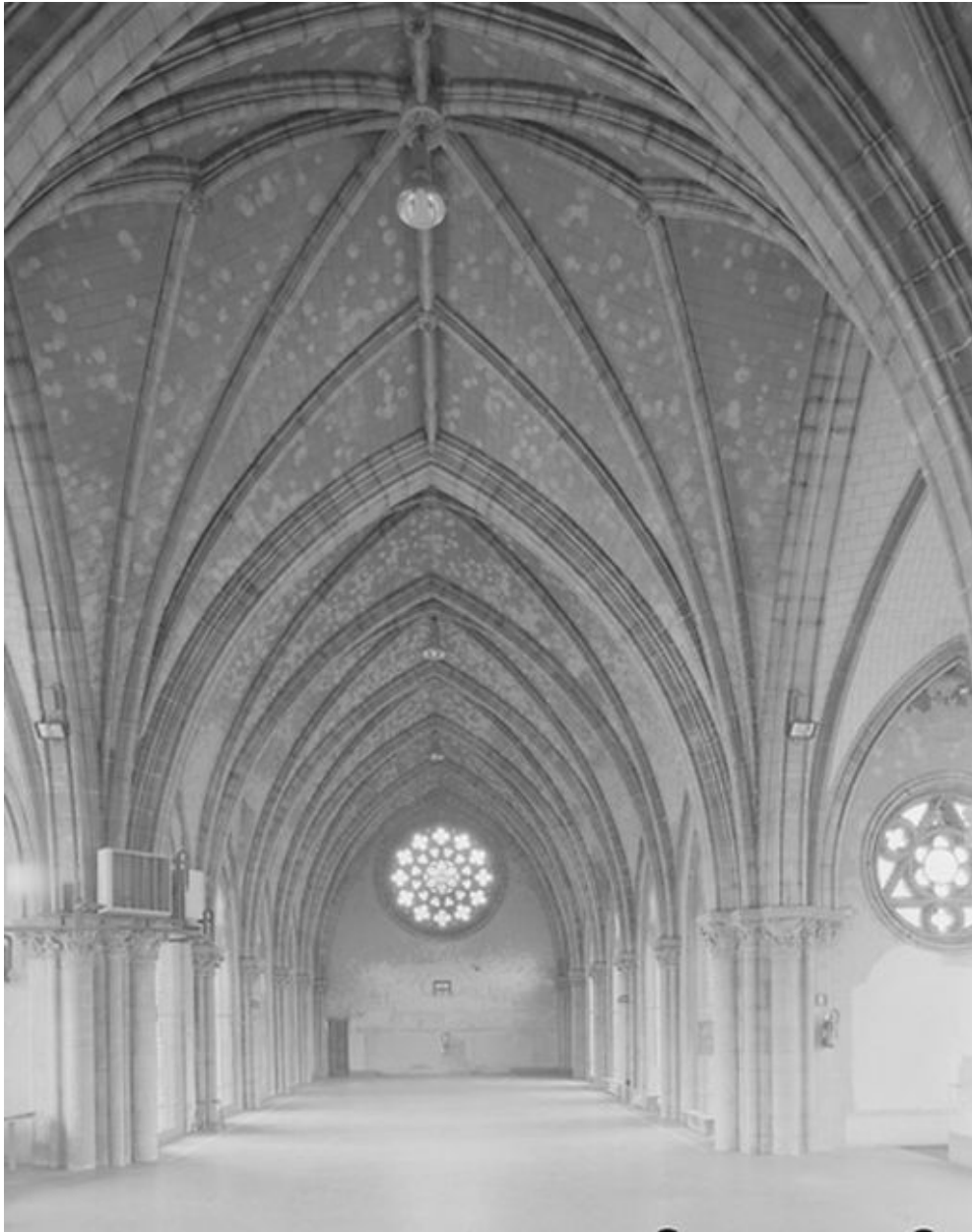
Vue intérieure vers l'entrée, partie haute.
