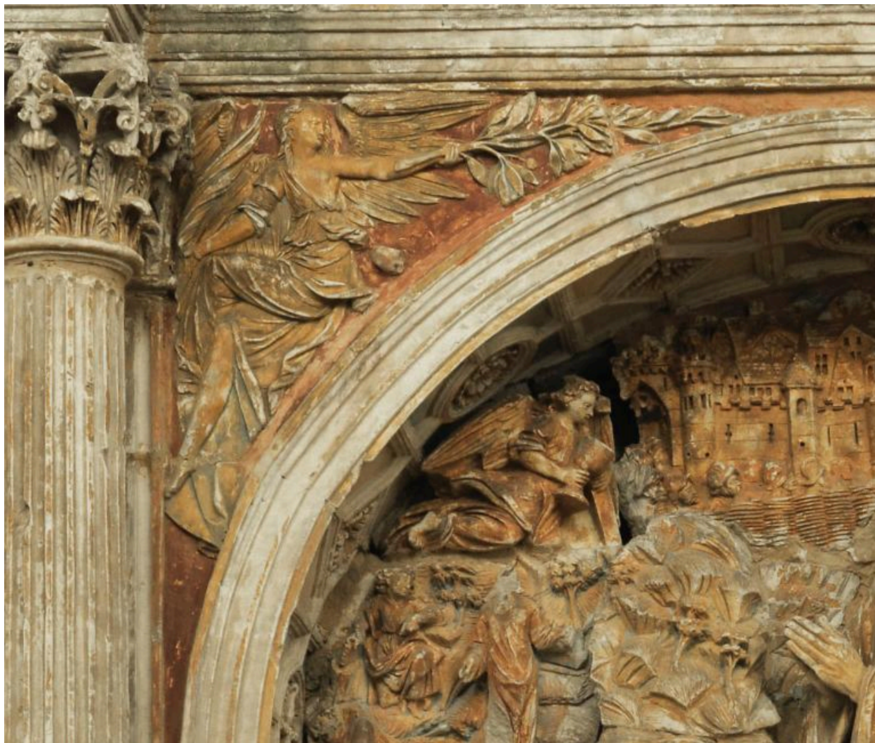
Détail d'un écoinçon de l'arcade centrale.
