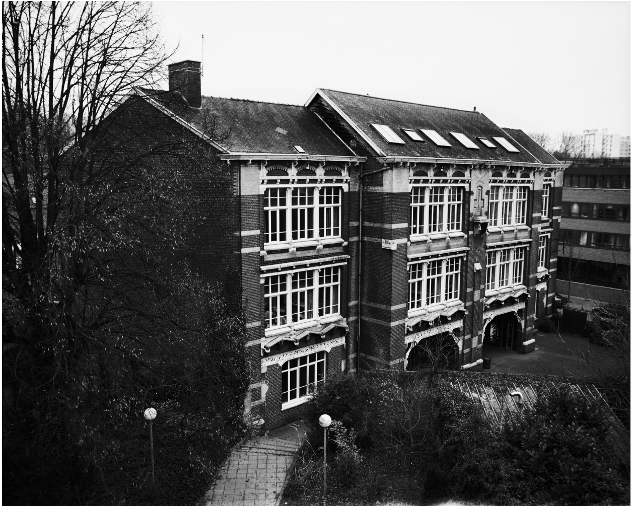
Vue générale de l'école primaire sur la cour.
