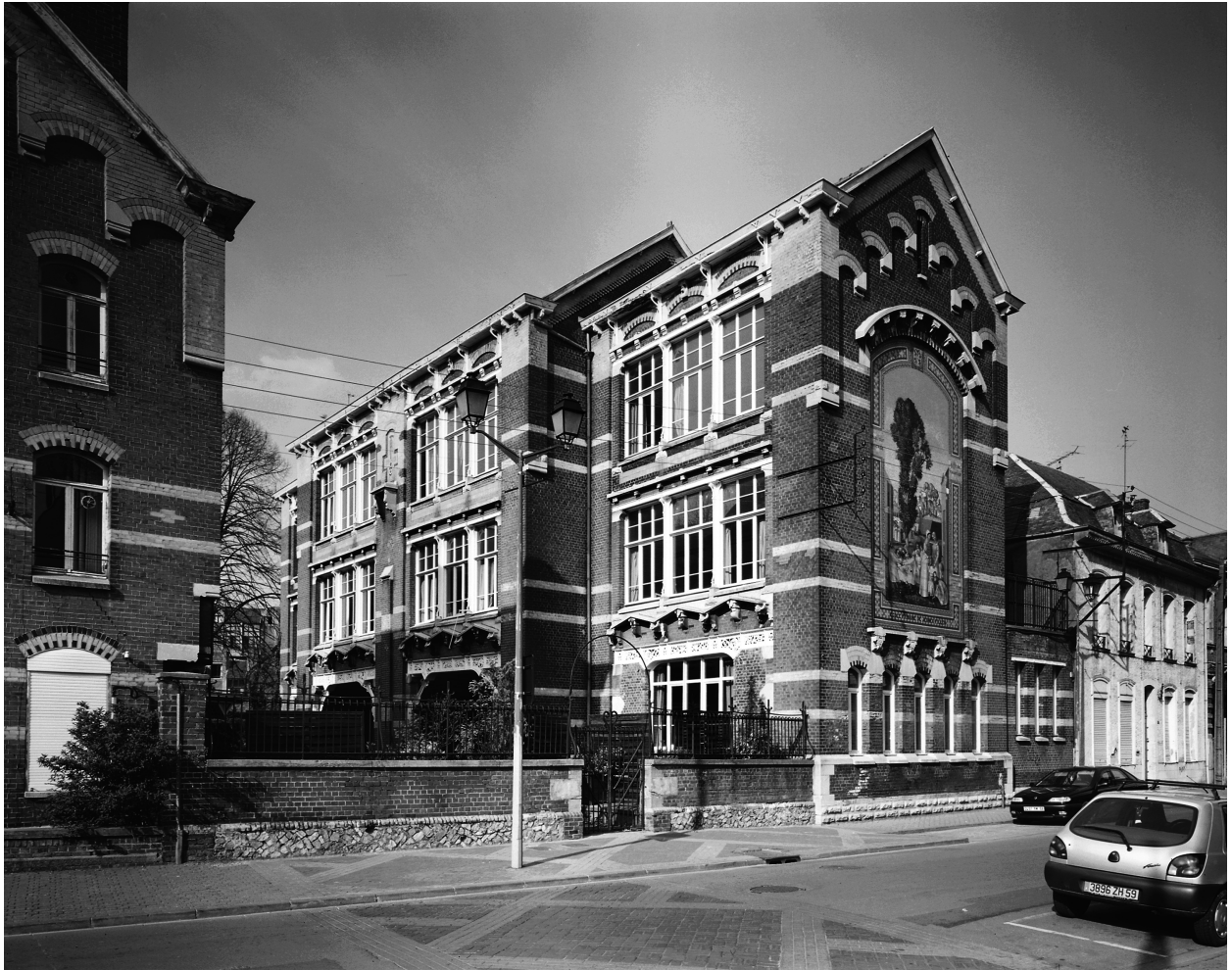
Vue générale de l'école de filles depuis la rue de la Croix.
