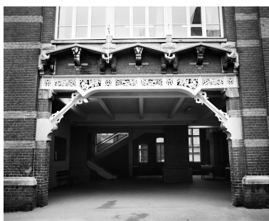
Troisième travée (depuis la rue) du rez-de-chaussée de l'école primaire : poutrelles de fonte décorées de papillons, coqs, sauterelles et feuillage. Phot. Thierry Petitberghien IVR31_20025900363X
