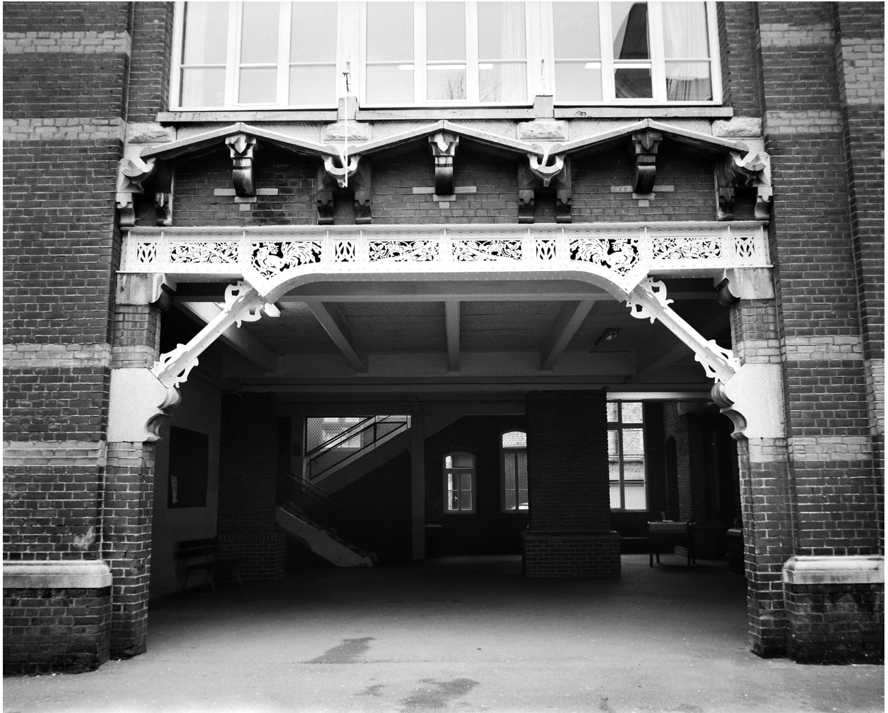
Troisième travée (depuis la rue) du rez-de-chaussée de l'école primaire : poutrelles de fonte décorées de papillons, coqs, sauterelles et feuillage.
